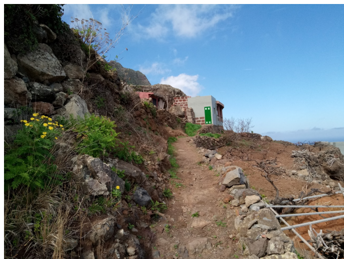
Vista del tramo final del sendero donde la nueva pista se separa del mismo, PK 0+150
