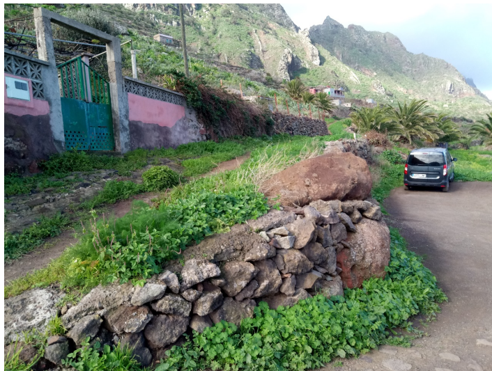
Vista del inicio de la pista, PK 0+000
