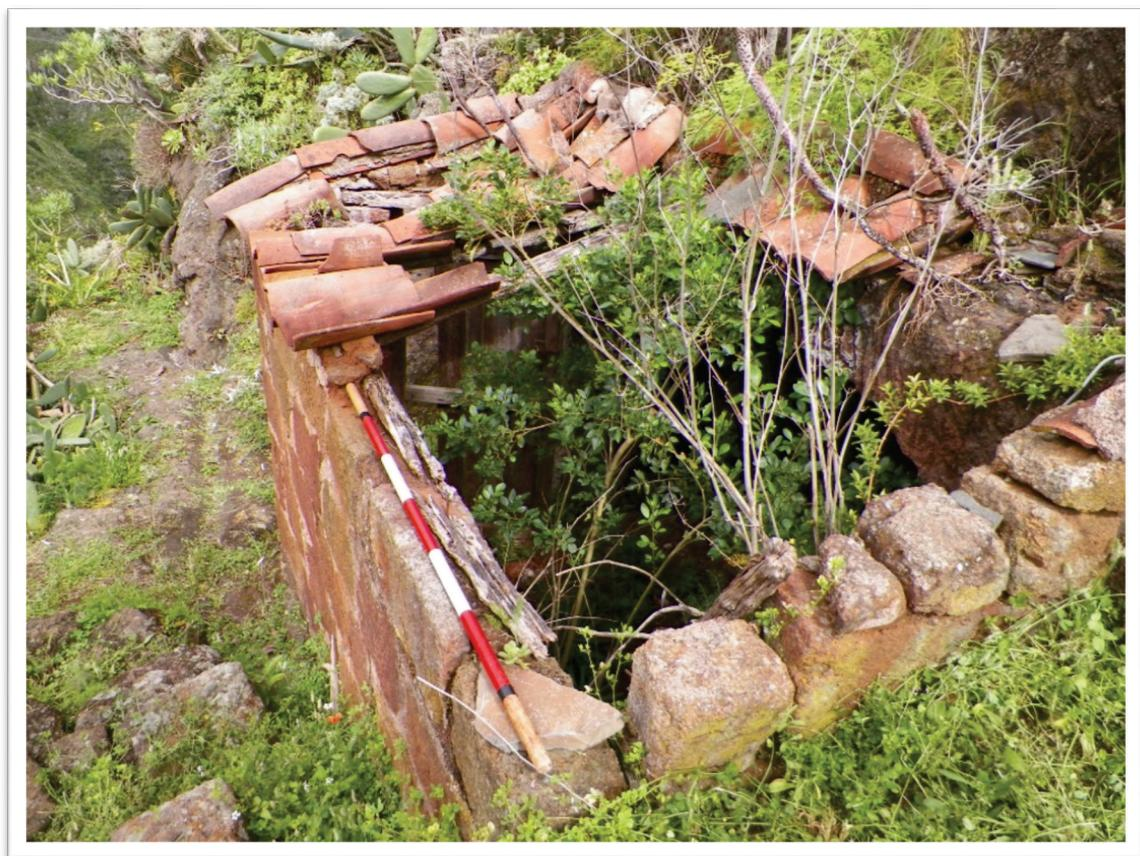
Fig. nº 21. Exterior de la gañanía, con la cubierta en estado de derrumbe
