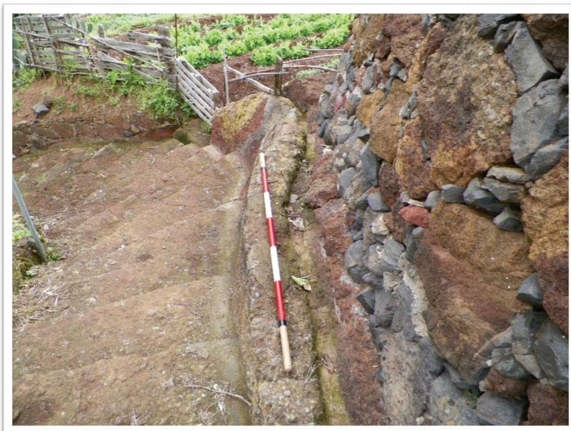
Fig. nº 14. Muro perimetral del trayecto junto al que se pueden observar los dos canales
