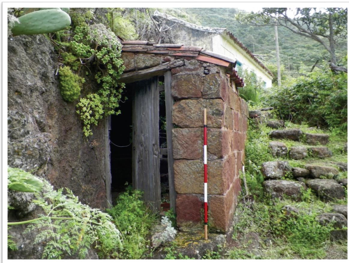
Fig. nº 7. En primer plano la gañanía excavada en la toba, con muro perimetral y techumbre. Junto a la misma transcurre el camino prospectado. En un segundo plano, en la parte superior, la vivienda tradicional.
