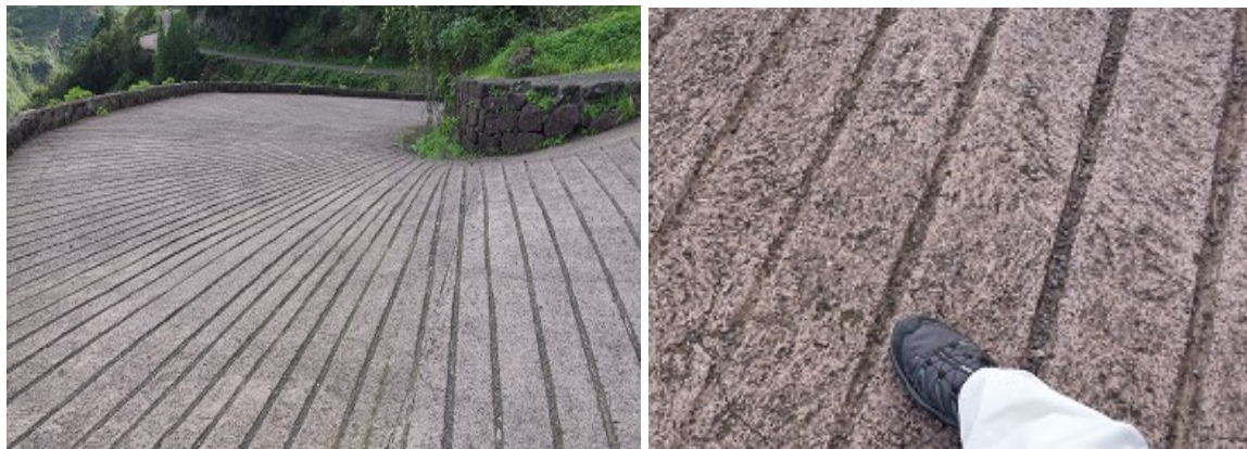
Detalle de ruleteado superficial en capa de rodadura de hormigón. Lugar: El Batán de Arriba
