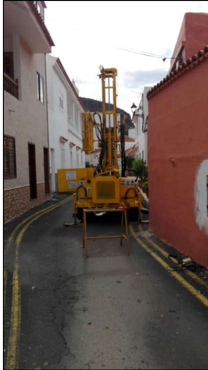
Emplazamiento del sondeo S-1
