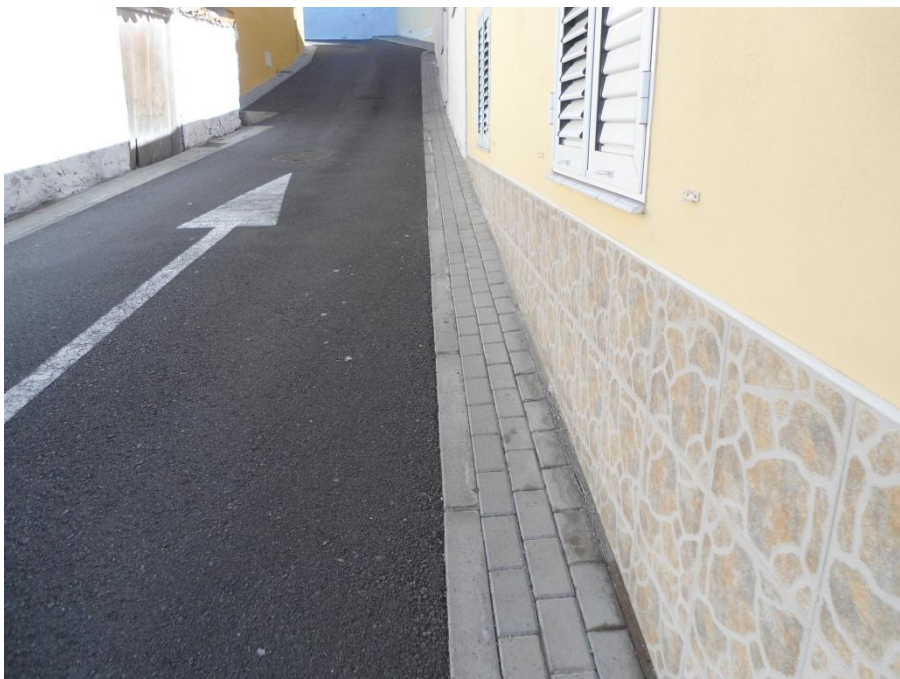
Pavimento de adoquín colocado en Fase 1
