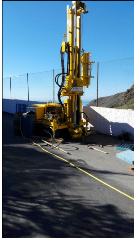
Emplazamiento del sondeo S-3
