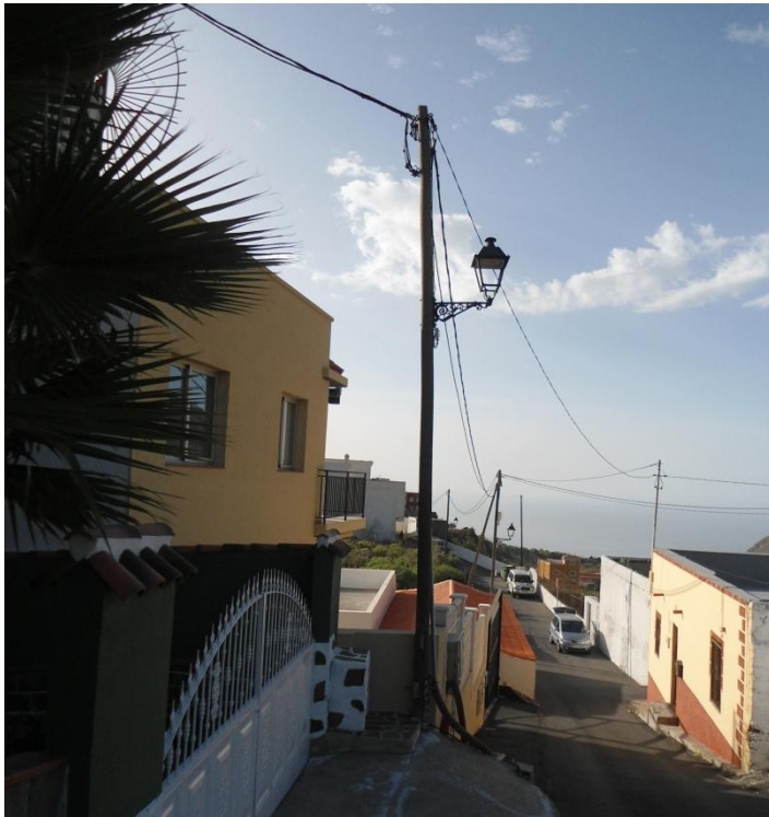
Farola adosada a poste de madera.
