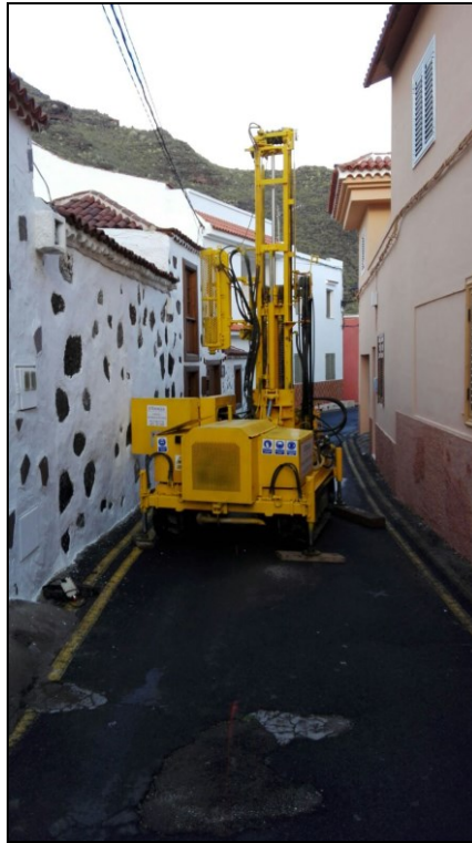
Emplazamiento del sondeo S-2
