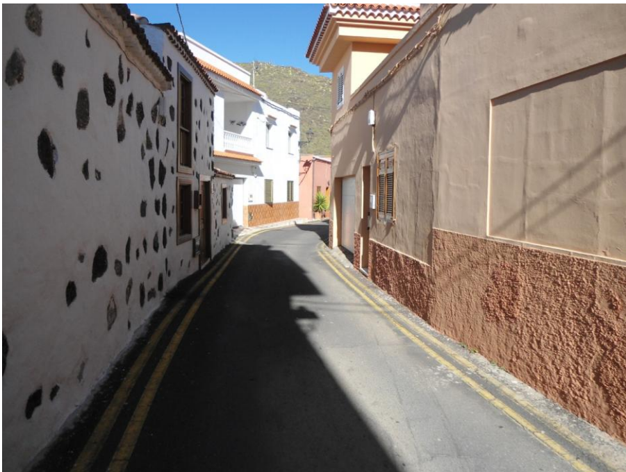
Zona sin acera en la calle El Agua
