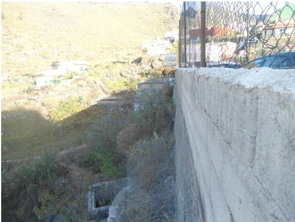
Muro que hay que atravesar para verter en el barranco.
