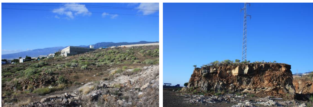
Vista panorámica de una de las rampas que conforman el Sector El Chorrillo Industrial (izqda.) y detalle de estructura relictas derivada de los desmontes ejecutados (dcha.).
