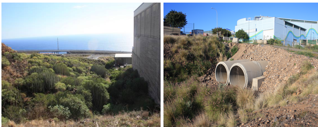
Barranco del Binoco (izqda.) y obra de paso asociada (dcha.).
