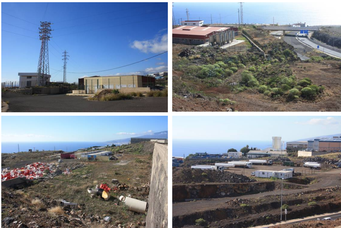
Vistas de la estación transformadora y EDAR de El Chorrillo (arriba), albergue canino (abajo izqda.) y área de estacionamiento de vehículos (abajo dcha.).
