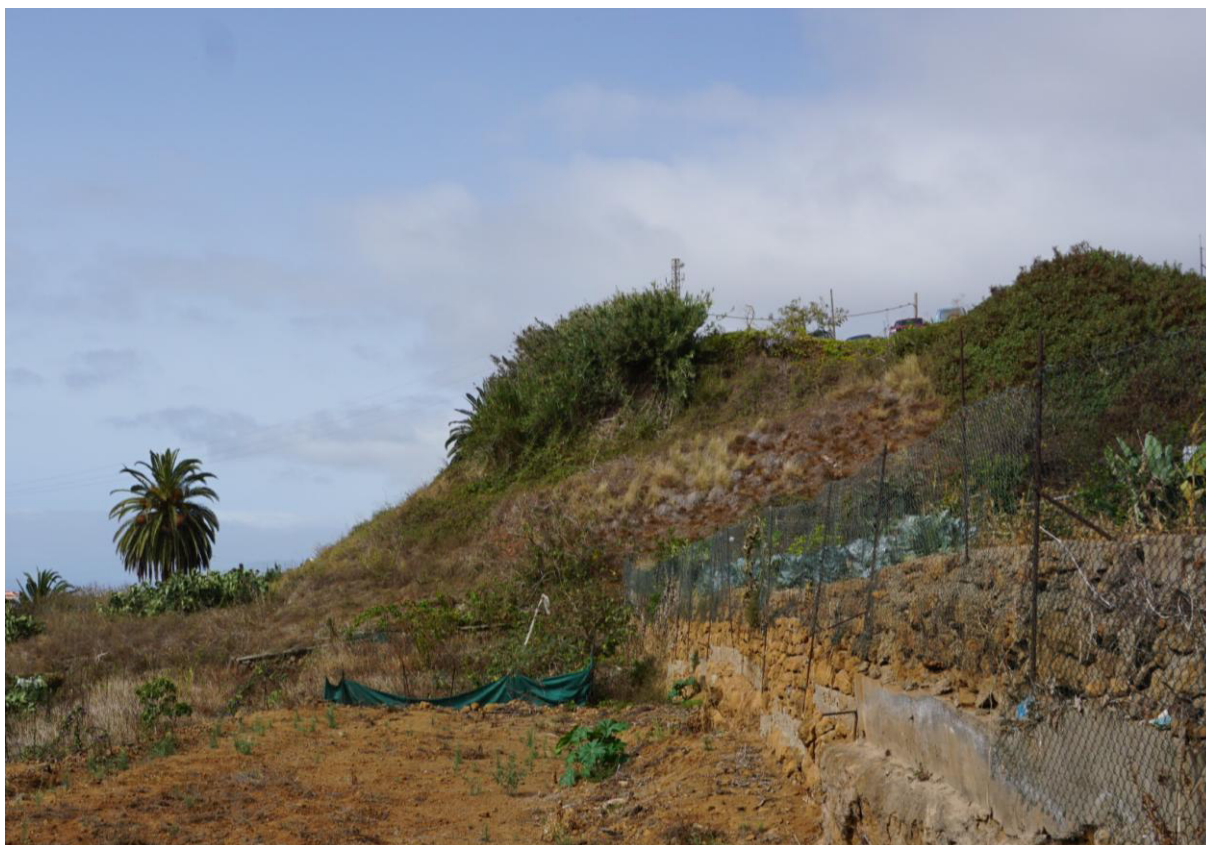
Imagen: Talud de depósitos antrópicos.
