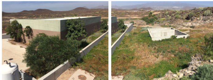
Imágenes 4 y 5. Detalles de las actuales instalaciones componentes de la ETAR de Amarilla Golf (izqda.) y del espacio anexo disponible para la recepción de la EDAR transitoria (dcha.).
