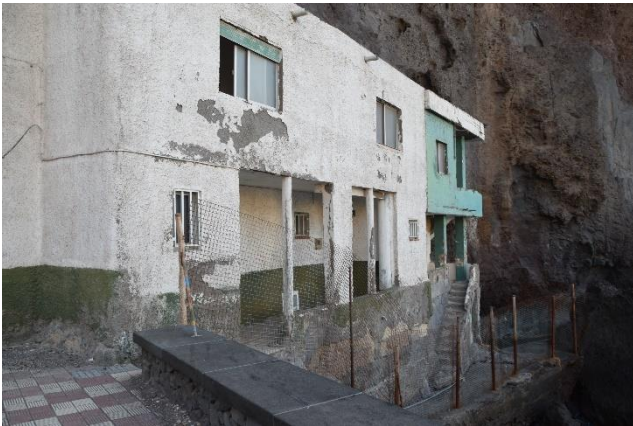
Foto 23. Viviendas en línea de costa en mal estado
