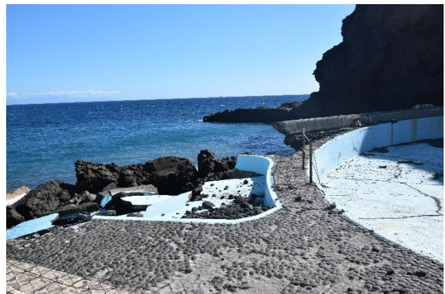
Foto 38. Rotura de muro y parte de piscina_2
