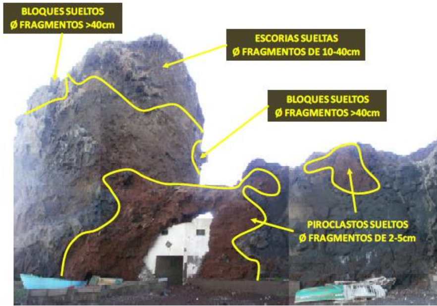
Imagen 45. Vista general del vértice NW del Roque y del istmo de roca donde se ha construido el arco artificial
