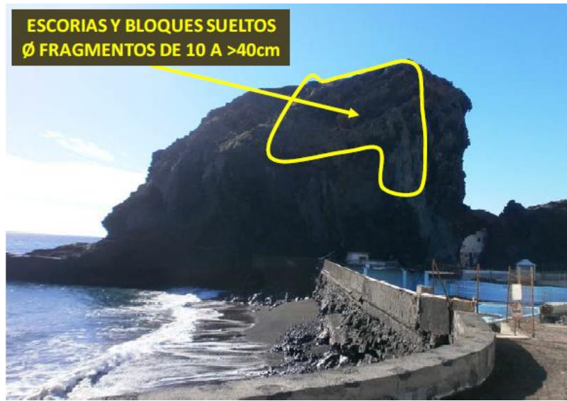
Imagen 47. Vista general de la vertiente NE y sector donde se producen la mayoría de los problemas de desprendimientos
