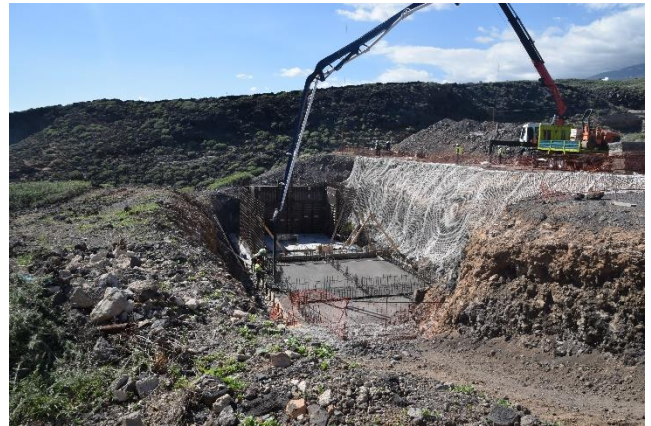
Foto 48. Ejecución de la EDAR junto al tabaibal localizado en el sur del área de estudio
