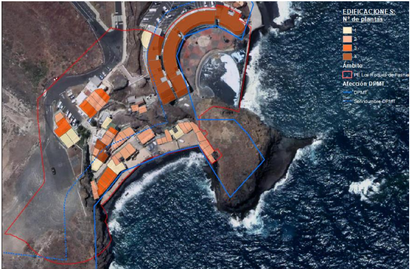
Edificaciones existentes en el Área del Plan Especial. Elaboración propia.
