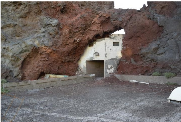
Foto 25. Pavimento en mal estado previo al túnel de conexión con la playa de Los Roques
