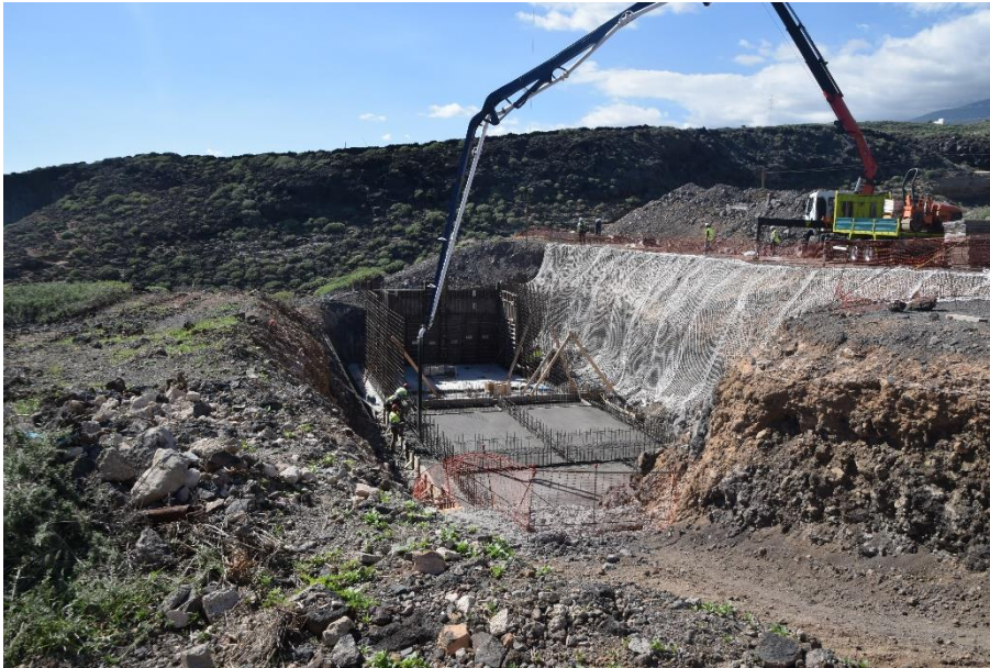
Foto 1. Ejecución de la EDAR Los Roques de Fasnia
