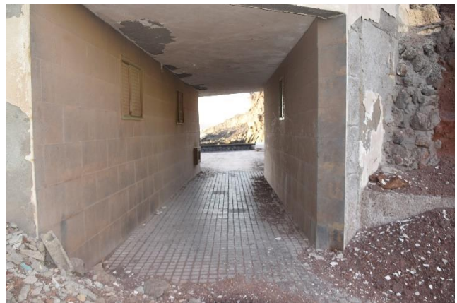
Foto 26. Pavimento del túnel que conecta los apartamentos Bahía con la Playa de Los Roques
