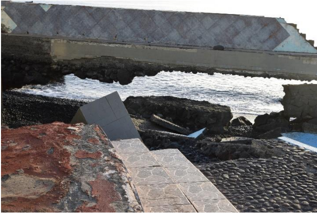
Foto 35. Rotura del muro de protección
