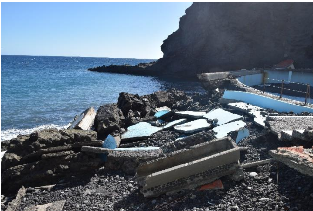
Foto 37. Rotura de muro y parte de piscina_1
