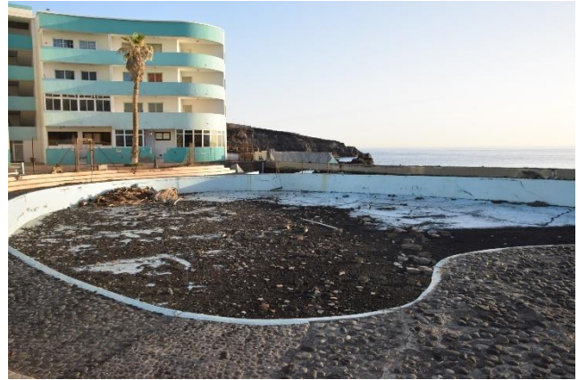
Foto 36. Vista de la piscina desde la explanada. Margen sur
