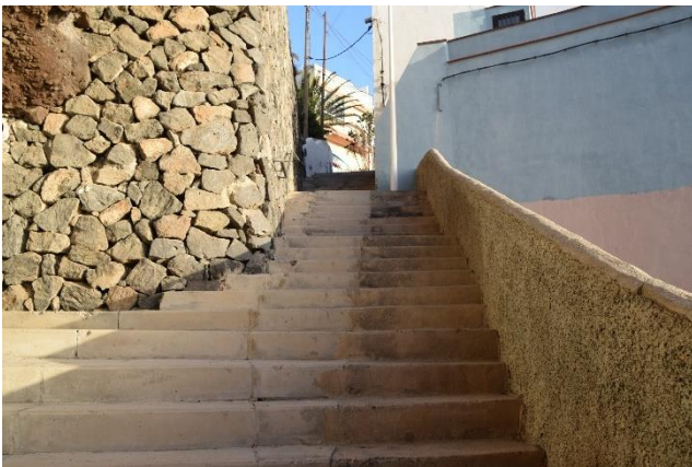
Foto 31. Último tramo de escaleras del peatonal interior
