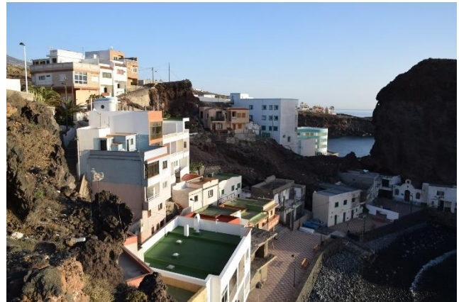
Foto 24. Vista general de viviendas unifamiliares
