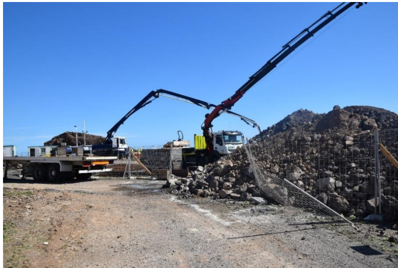
Foto 45. Ejecución de la EDAR Los Roques de Fasnia
