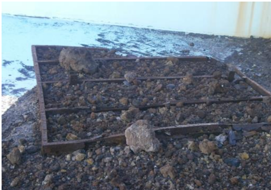
Imagen 49. Fragmentos desprendidos en la zona de la piscina con tamaños comprendidos entre los 10 y > de 40 cm Ø
