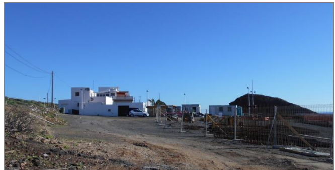
Ejecución de la EDAR de Los Roques de Fasnía.
