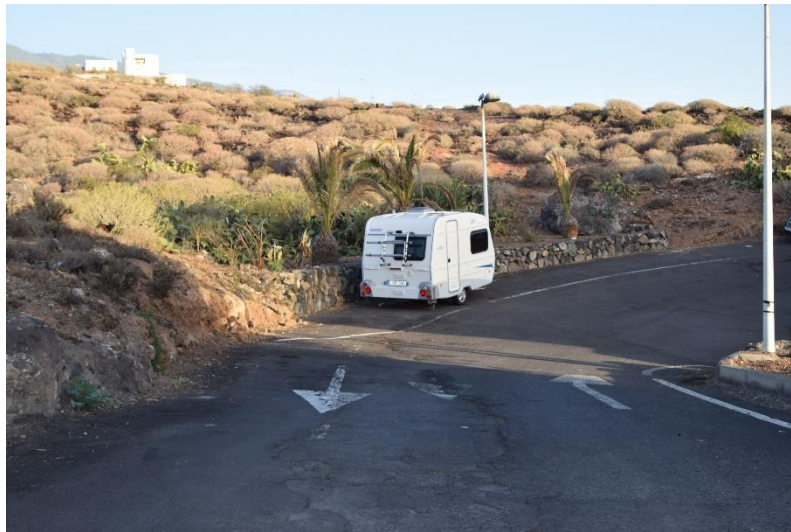
Foto 12. Zona de desagüe de la barranquera sobre calle existente
