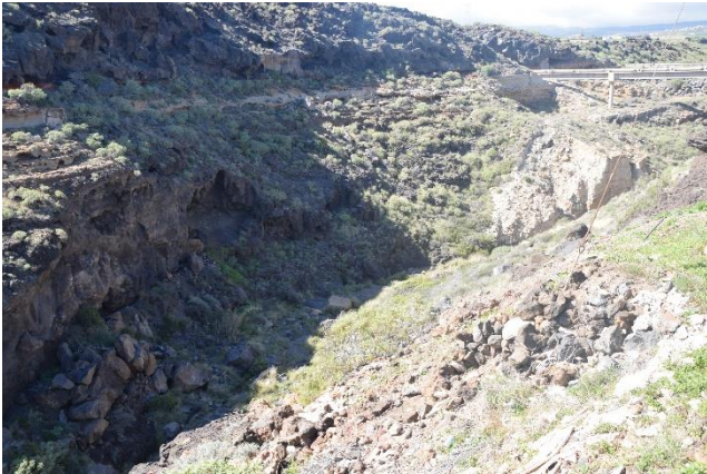
Foto 10. Tramo final del cauce del Bco. San Joaquín
