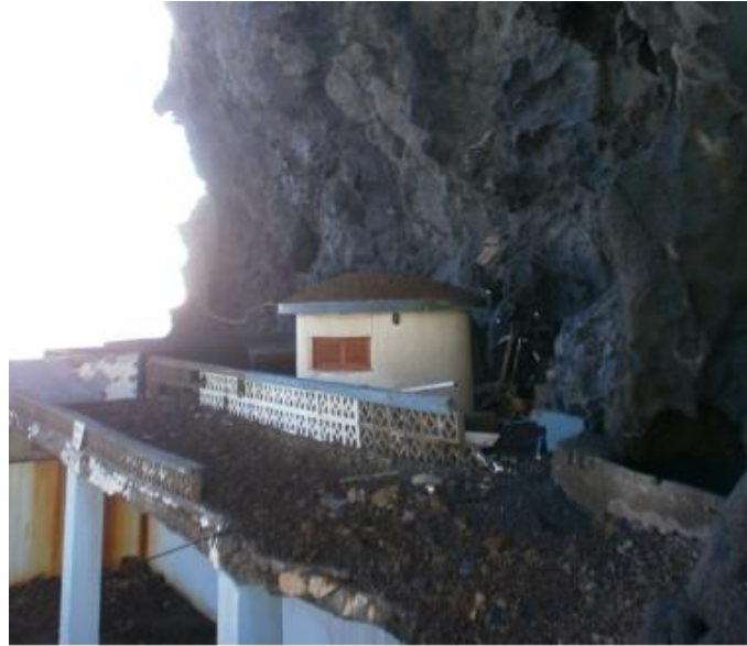
Imagen 48. Zona de desplome junto a la piscina y fragmentos desprendidos desde la parte alta
