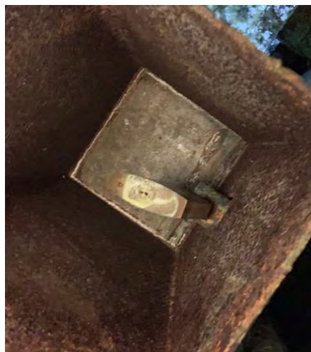
Figura 2-4. Detalle del otro candado de cierre y de la campana de protección
