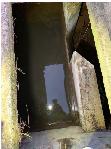
Figura 2-5. Detalle del segundo compartimento de aforo y del vertedero rectangular de la tanquilla
