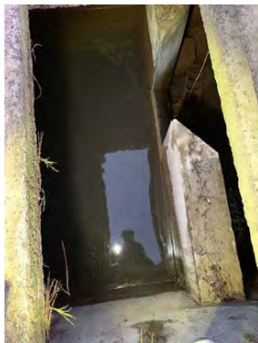
Figura 1-2. Vista general del interior de la tanquilla de aforo
