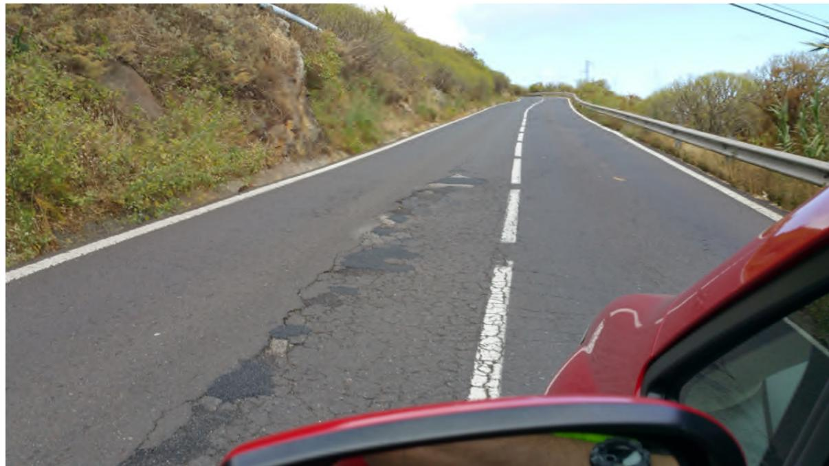
*Tramos descarnados con reparaciones puntuales con asfalto en frío*
