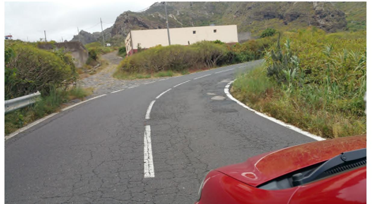
*Disuraciones y descarnados con reparaciones puntuales con hormigón*
