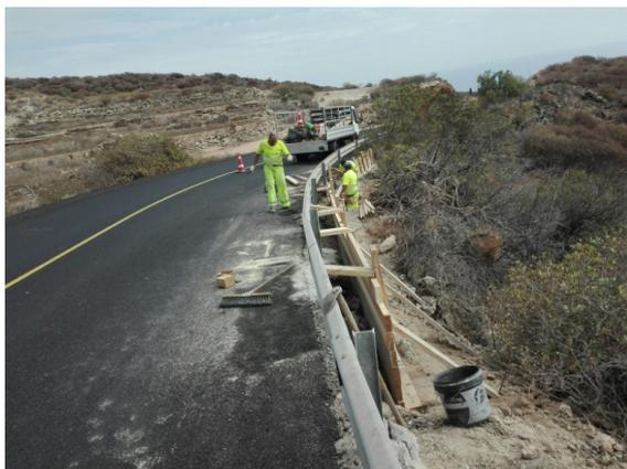
Foto. Ejemplo de colocación de encintado de hormigón para sostenimiento de barrera de protección en la TF-617
