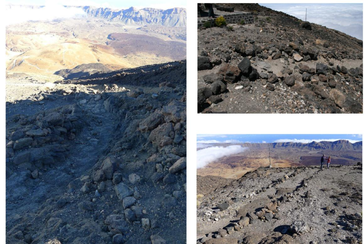
Trazado del Sendero en el tramo de salida del Refugio en sentido descendente (i), con aspecto disgregado y altamente erosionado. Presencia de caminos provocados y restos de materiales aportados (d).
