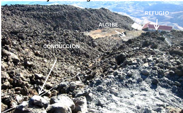
FOTO 2 Conducción de unión Aljibe del refugio de Altavista con el teleférico.
