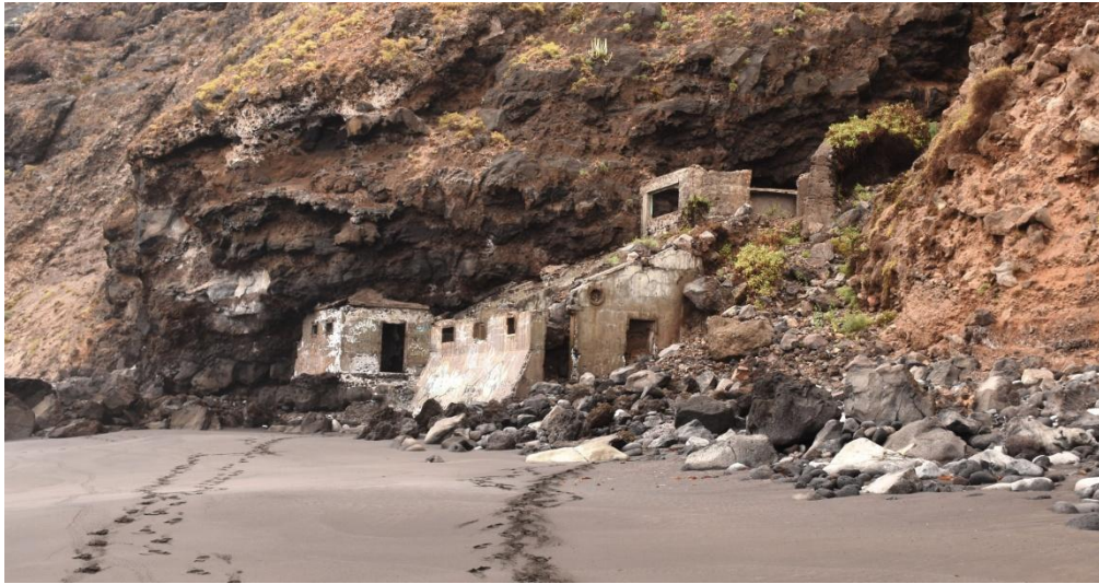
Figura 10. Galerías y pozo Cueva del Agua o El Ancón
