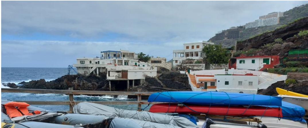
Figura 12. El Caletón. Al fondo, edificios urbanización Puntillo del Sol
