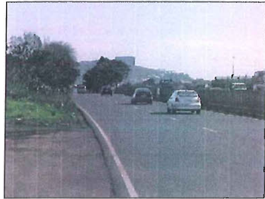
CARRETERA GENERAL DEL NORTE C 820
