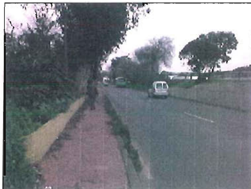
CARRETERA GENERAL DEL NORTE C 820
