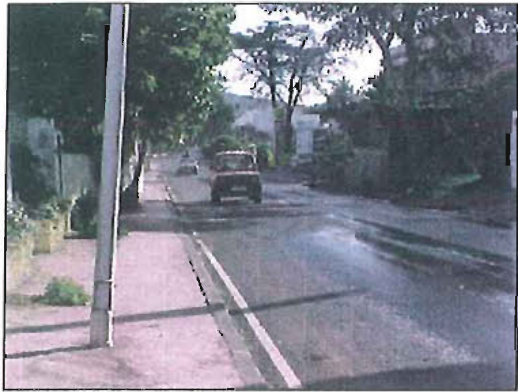
CARRETERA GENERAL DEL NORTE C 820
