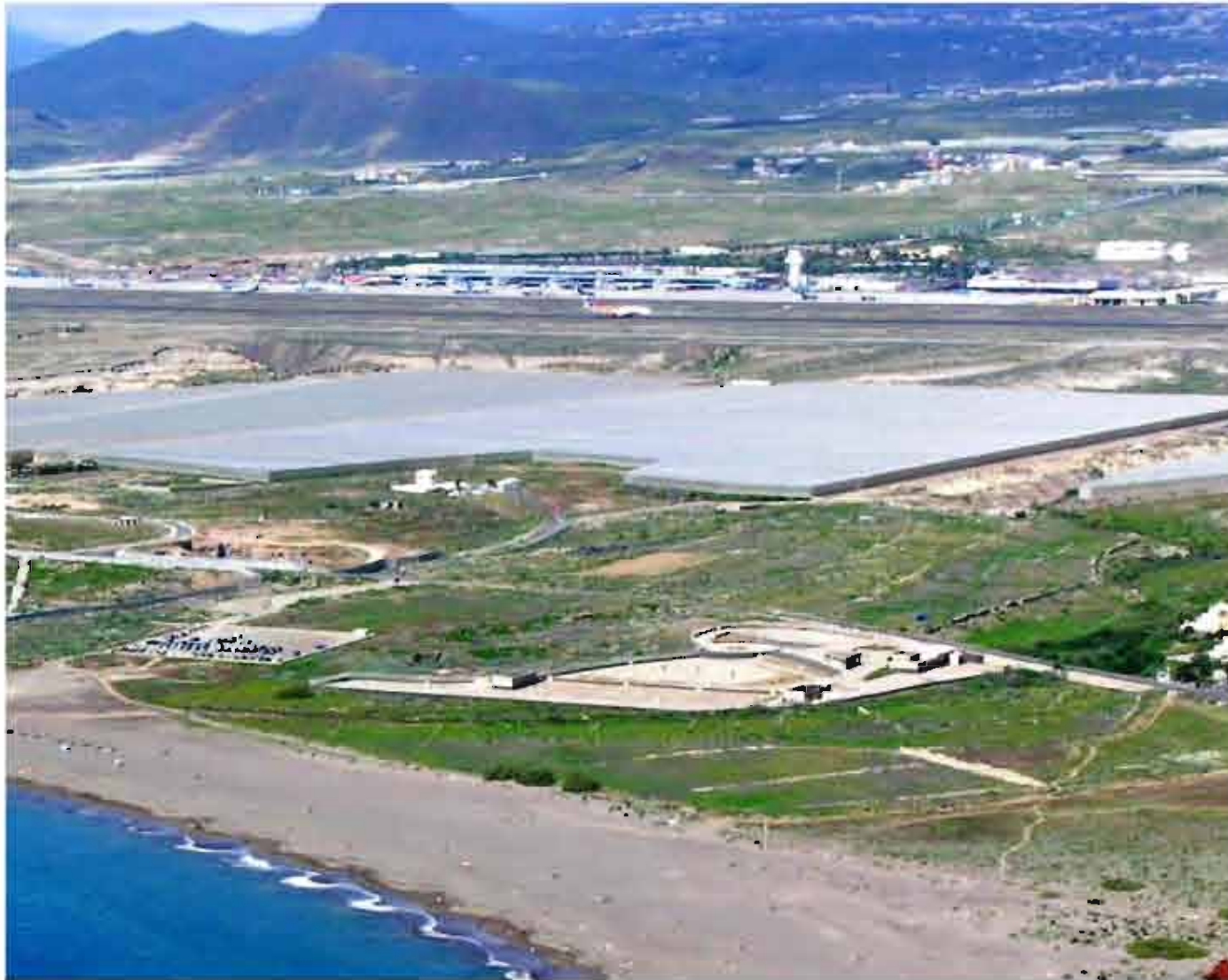
Fig.7: Vista General del Aeropuerto Reina Sofía.
