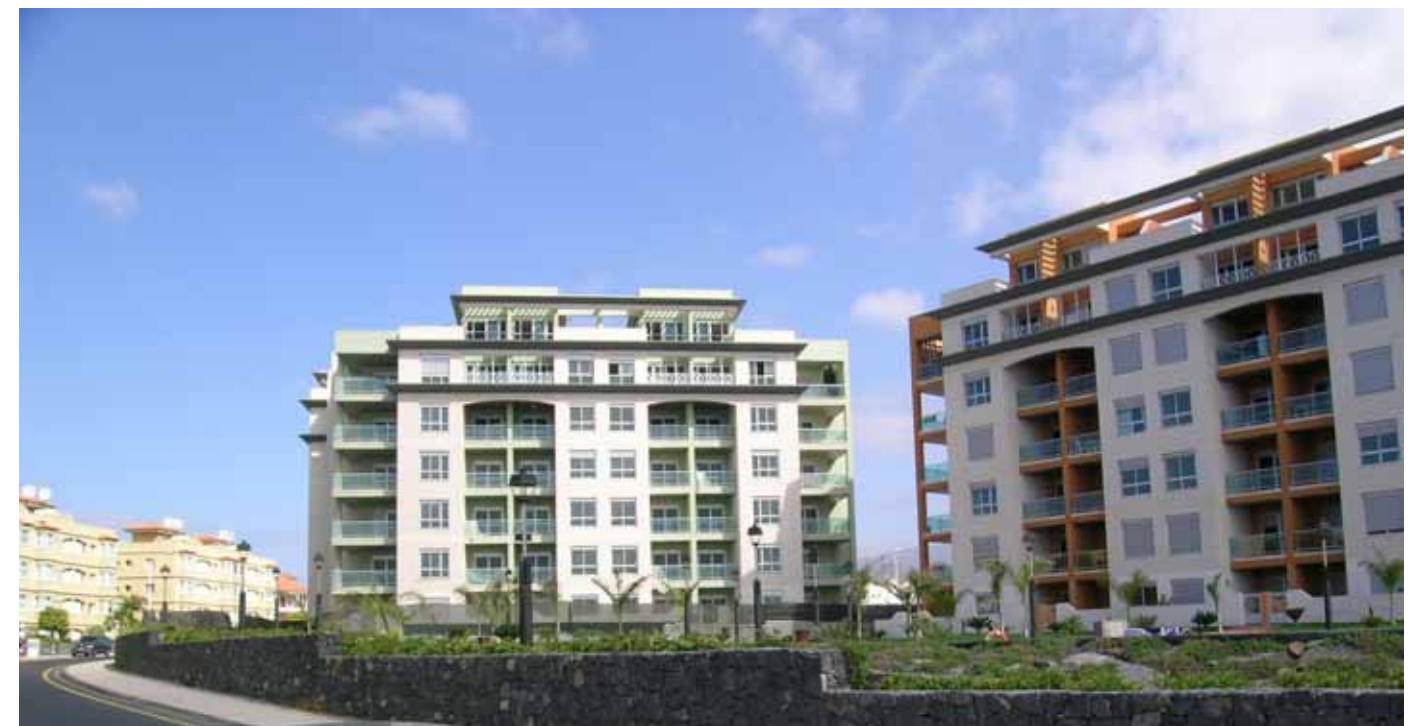
Fig. 31. Sup. Vista aérea de la edificación cercana a la costa de la Urbanización Amarilla Golf. Inf.: Vista interior de grupos de edificación reciente en la Urbanización Amarilla Golf.
