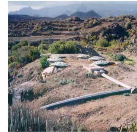
Conducción de desagüe Pebble Beach Village
