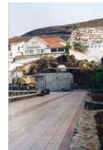
Emisario Submarino del Puerto de Los Cristianos
