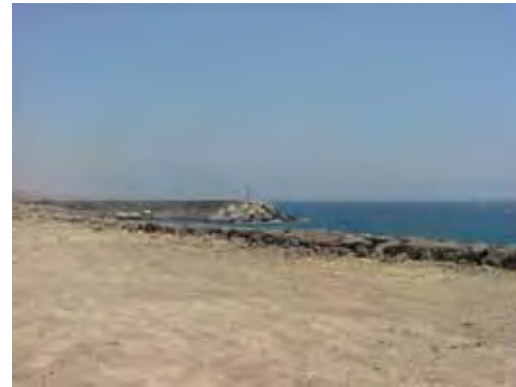
Conducción de desagüe de la Central de Granadilla
