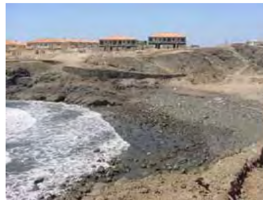
Emisario Ensenada de Pelada
