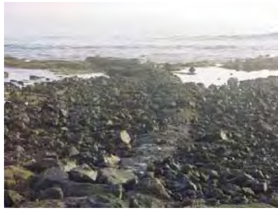
Conducción de desagüe del Camisón
