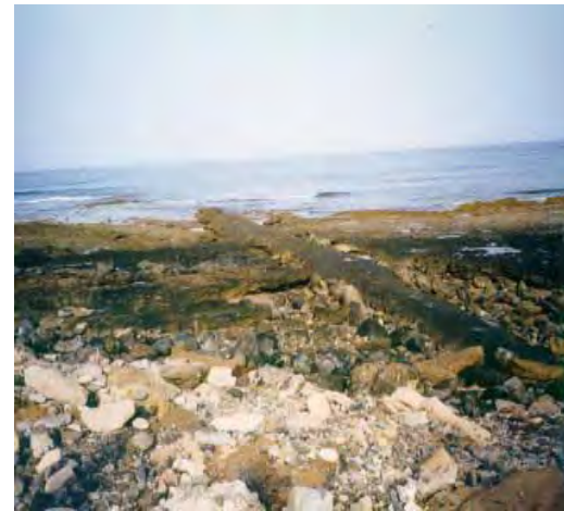
Conducción de desagüe de la Playa del Troya
