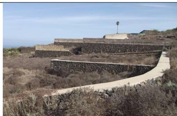
Imagen 2: detalle de los muretes existentes constándose que recientemente han sido los muros rematados con hormigón.
