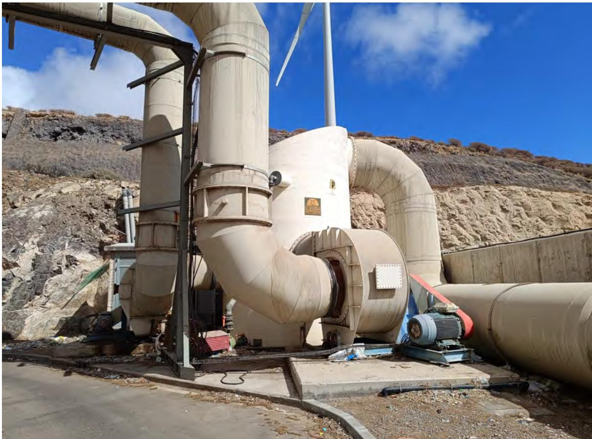
Imagen 8. Detalle de la actual torre de lavado con la que está dotada la nave de bio-estabilizado.
