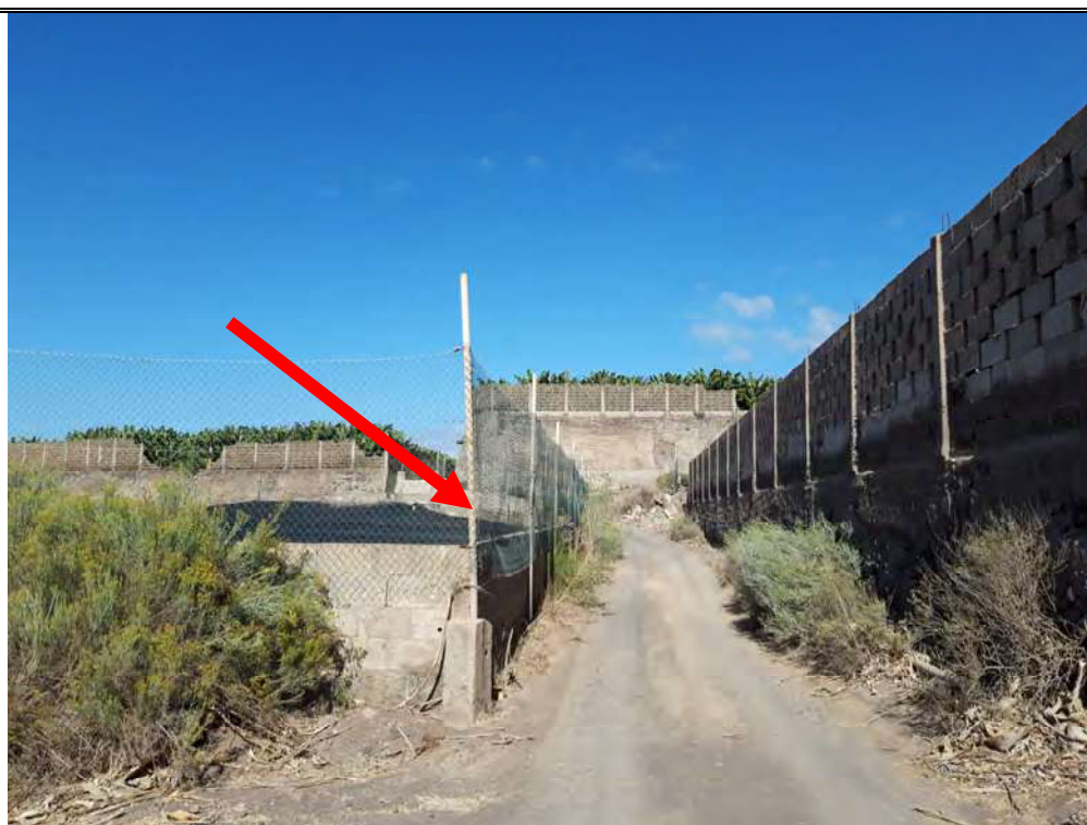
Imagen 5: PK 380. Depósito existente en la margen izquierda, que produce un estrechamiento en el camino.
