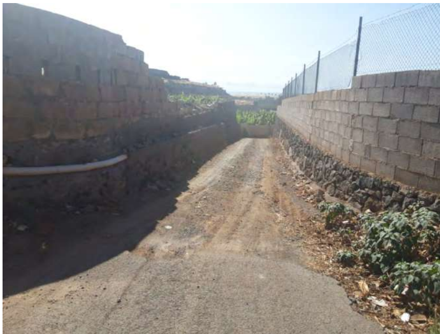
Final del camino y unión a camino asfaltado existente
