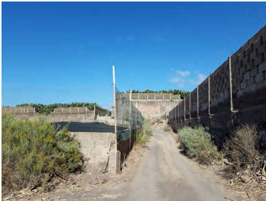
PK 0+380, depósito de agua a la izquierda.
