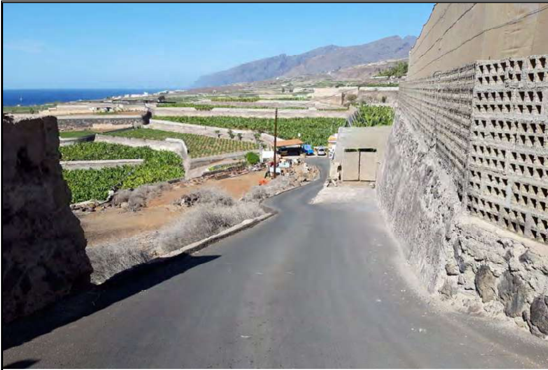
Imagen 14: PK 1.070. Ejecución de muro de contención + barrera metal madera en margen izquierda. Apartadero existente en la margen derecha del camino.
