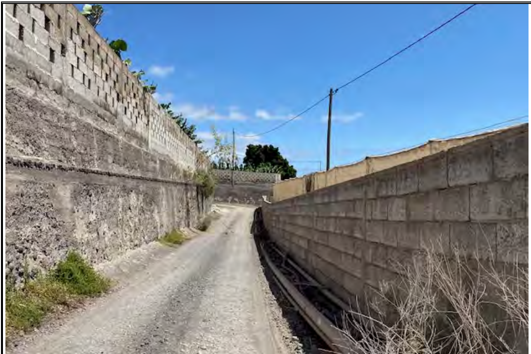
Imagen 2: PK 20. Se propone desbroce de los bordes, ejecución de murete de 70 cm de PK 05 a PK 30 en margen izquierdo, desplazamiento de conducciones existentes y preparación para asfaltado.
