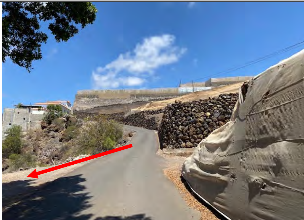
Imagen 15: PK 1.230. Apartadero existente en la margen derecha del camino. Nueva pavimentación del apartadero.
