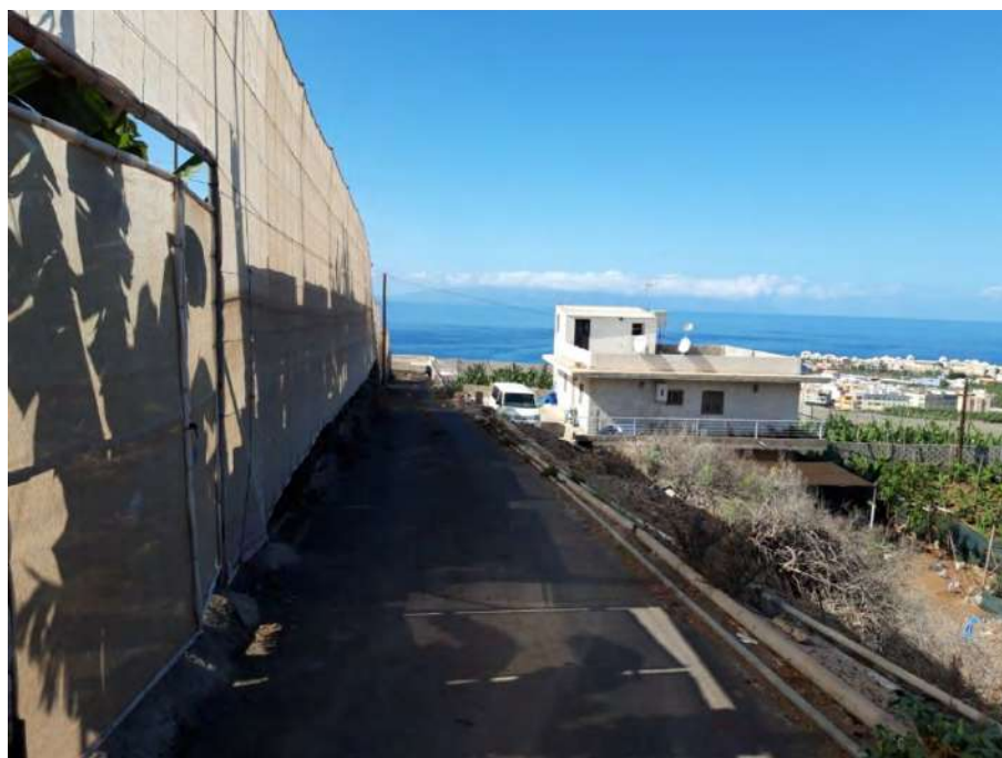
Inicio del tramo pavimentado con asfalto PK 0+940.
