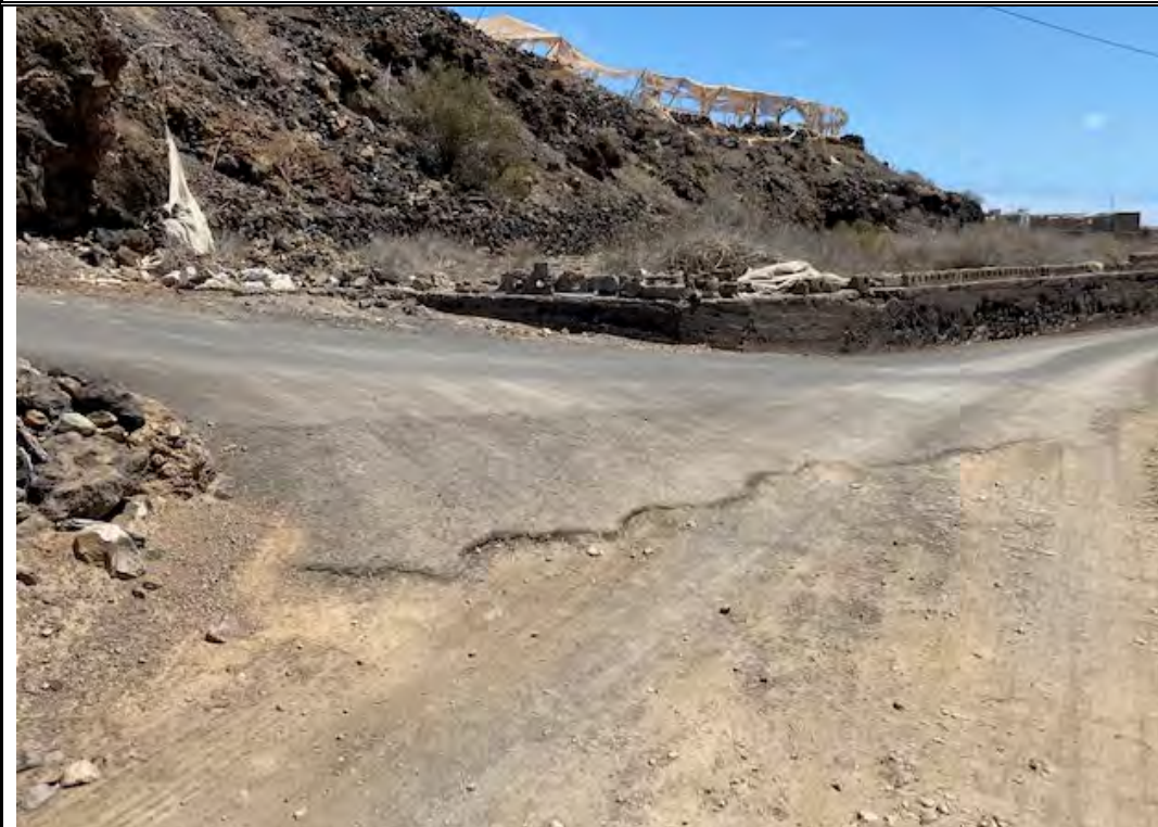
Imagen 17: PK 1.330. Cruce del Camino La Cumbrita con la C/Finca Lomo los Cerrillos.
