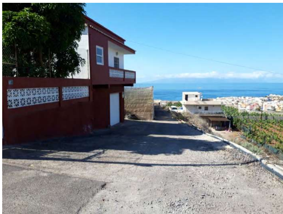
Inicio tramo de pavimento de hormigón, PK 0+910 al PK 0+940.
