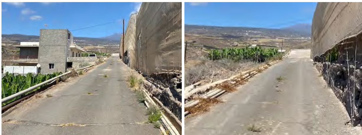
Estado actual del pavimento entre el PK 0+940 y PK 1+040.
