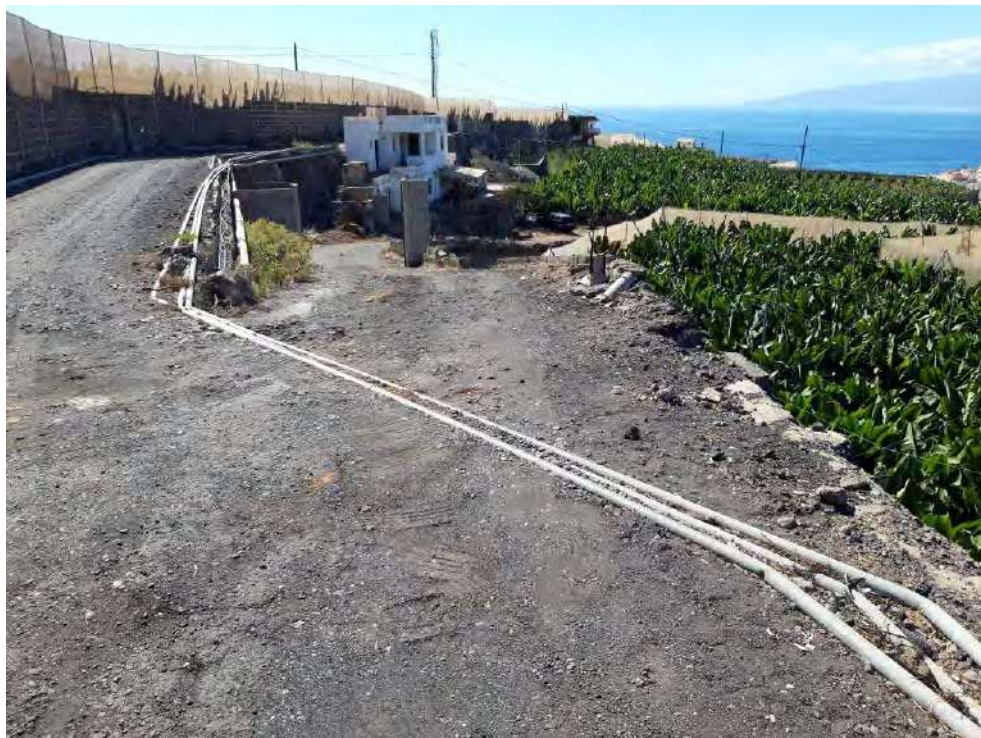
Zona a asfaltar a la derecha de la imagen y hormigonado entrada finca.
