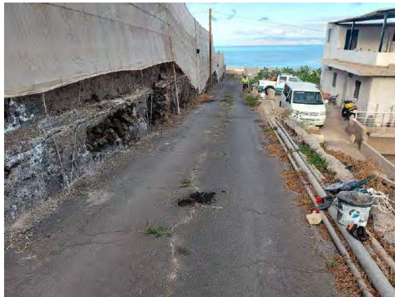
Ilustración 14: Vista general de prueba en PK 0+960.
