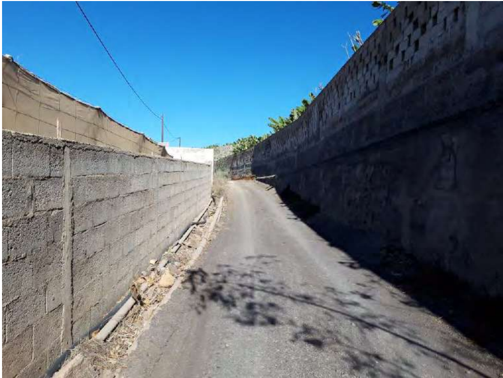
Imagen del inicio del camino Pk 0,00
