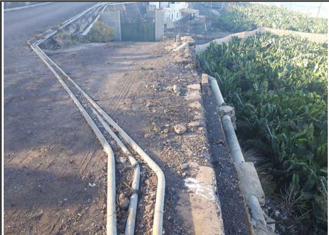
Imagen 10: PK 730. Soterrar tuberías para ejecución de entrada a parcela.
