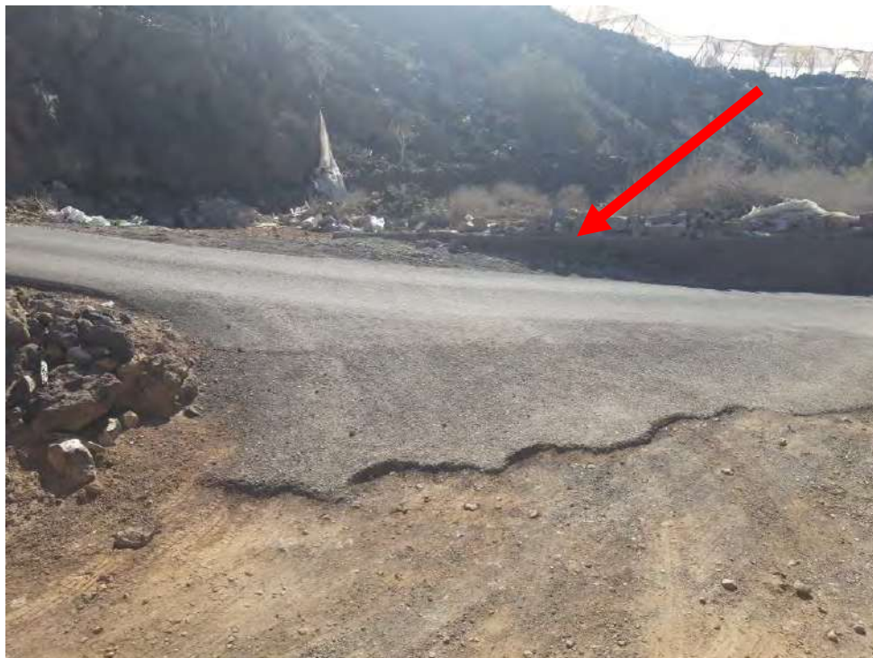
Mejora de la zona para adecuar radio de giro
