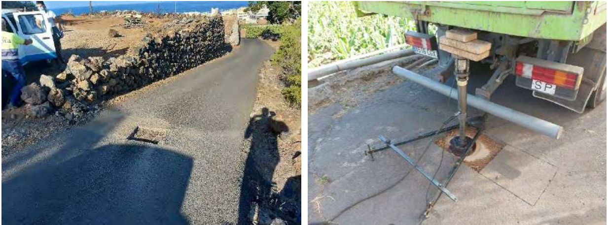
Ensayos de prueba de carga en el PK 1+190 y PK 0+990.
