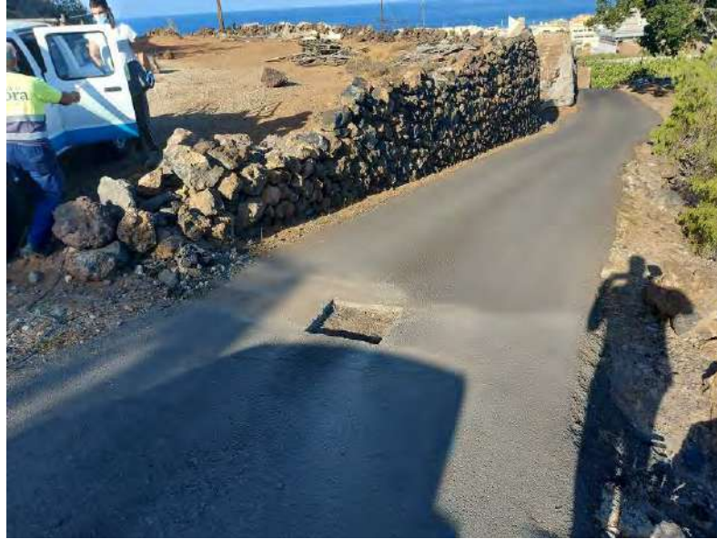
Ilustración 8: Vista general de prueba en PK 1+190.
