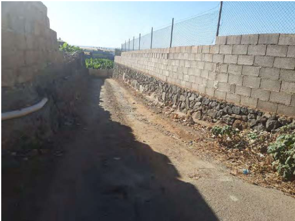
Vista final del camino con unión a camino existente.
