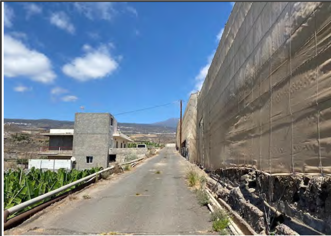
Imagen 12: PK 990. Se pasa de un ancho de 3,5m de pista a 3,25m, hasta el PK 1.030.
