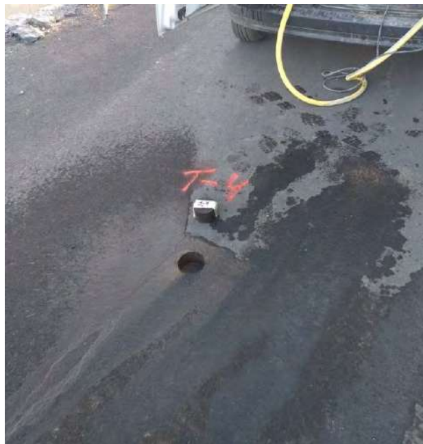
Ilustración 19: Ilustración 18: Vista del lugar de la extracción del testigo nº4.
