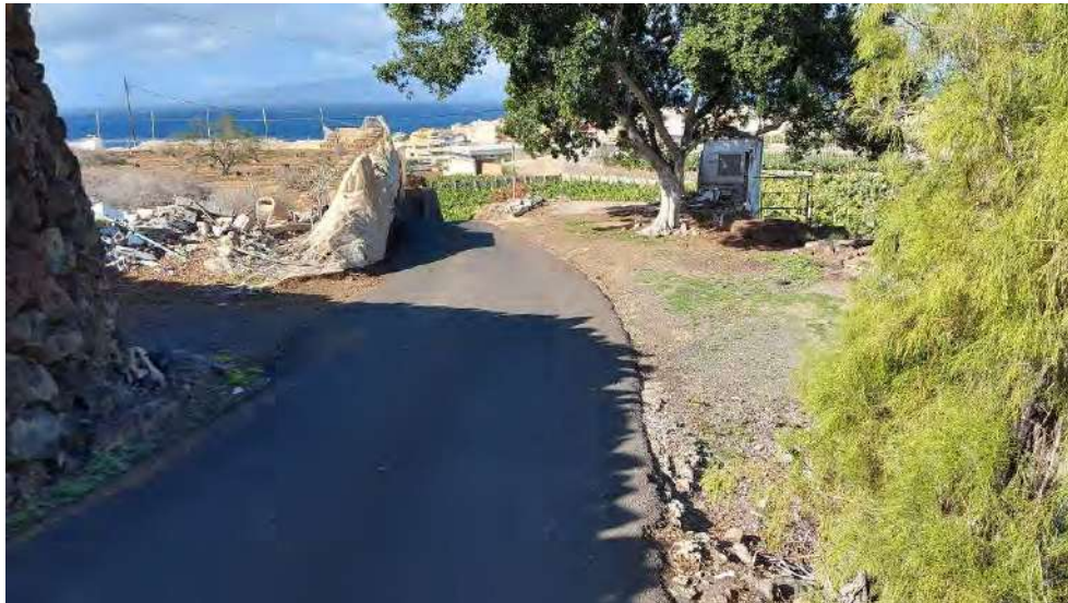
Ejecución de apartadero en la margen derecha del camino
