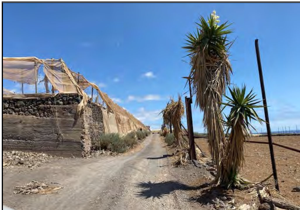
Imagen 4: PK 350. Se propone llevar el asfalto al muro del PK 355 al PK 410, al no caber la protección de borde, además de desbroce de los bordes y preparación para asfaltado.
