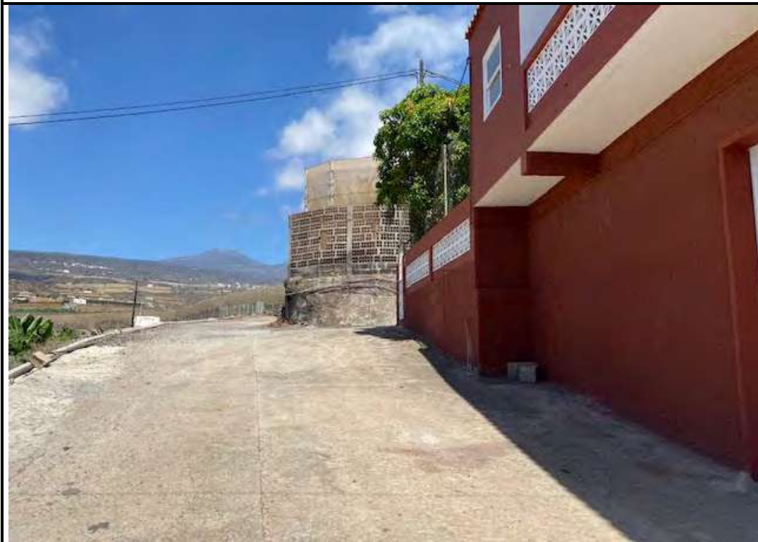
Imagen 11: PK 920. Demolición de solera de hormigón existente y asfaltado delante de edificación.
