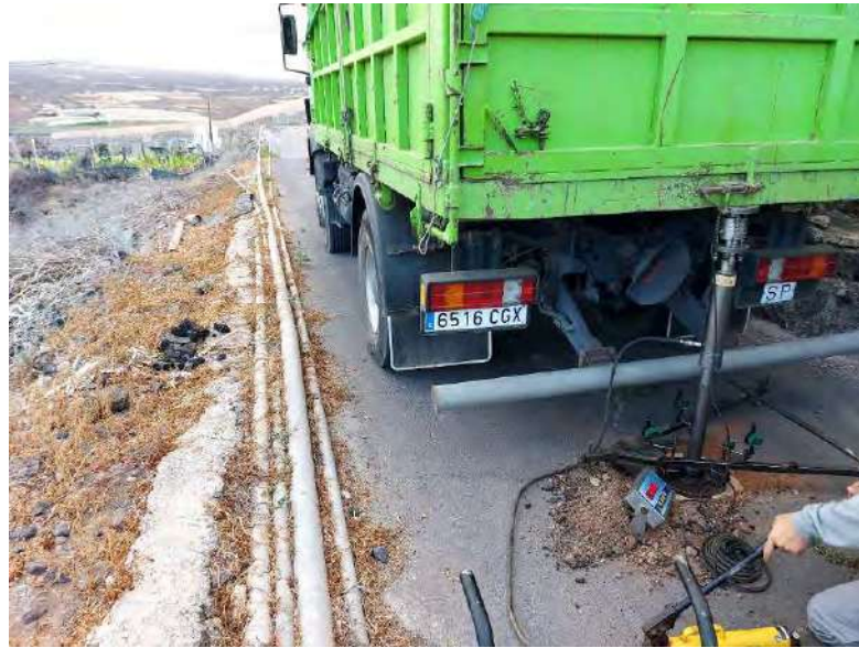
Ilustración 13: Prueba de carga Pk 0+960 (según acta de ensayo "Placa n°2" del 04/06/2021, Localización La Cumbrita Pk 0+990).
