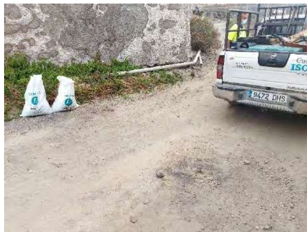
Estado actual del pavimento entre el PK 0+915 y PK 0+940.
