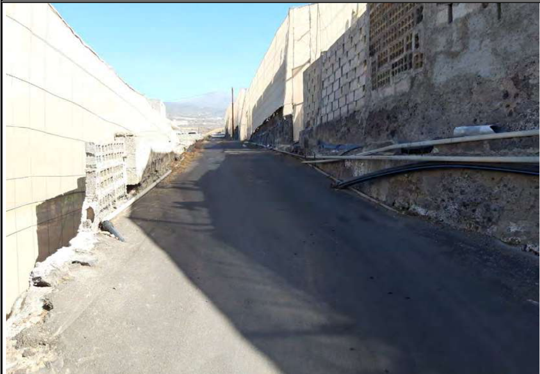
Imagen 13: PK 1.010. Ejecución de zuncho armado + barrera en margen derecha de PK 990 a PK 1.030.
