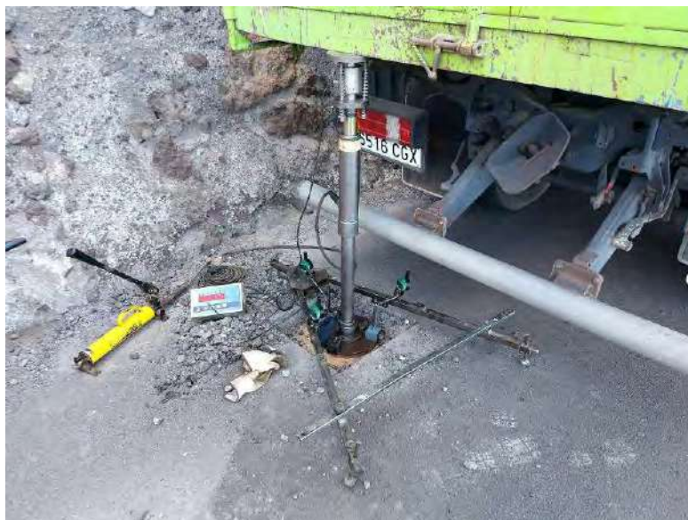
Ilustración 11: Prueba de carga Pk 1+125 (según acta de ensayo "Placa n°1" del 04/06/2021, Localización La Cumbrita junto a T-3).
