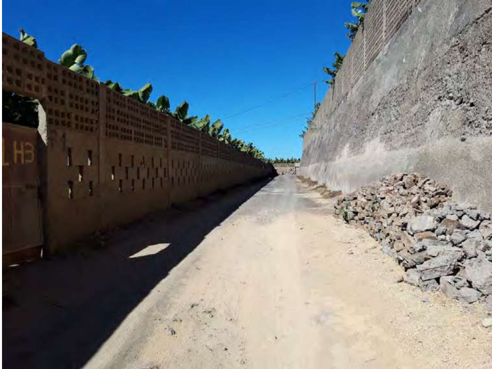
Tramo del camino existente entre el Pk 445 y 578 y que no se pavimentará
