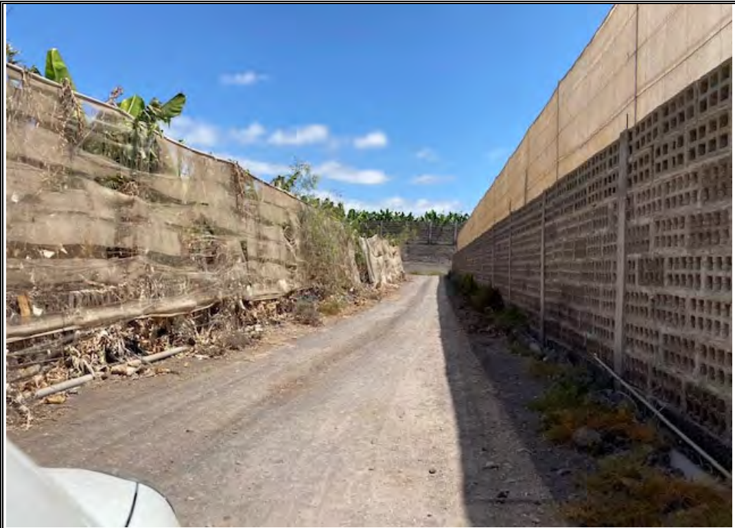
Imagen 8: PK 610. Levantado de tuberías para ejecución de asfaltado y/o protección de borde.
