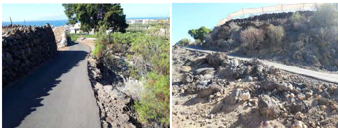
Zona a ubicar los muros (Pk 1.200 y Pk 1280)
