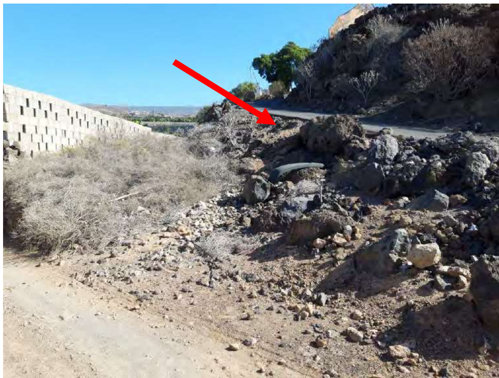
Zona a ejecutar muro de contención y apartadero
