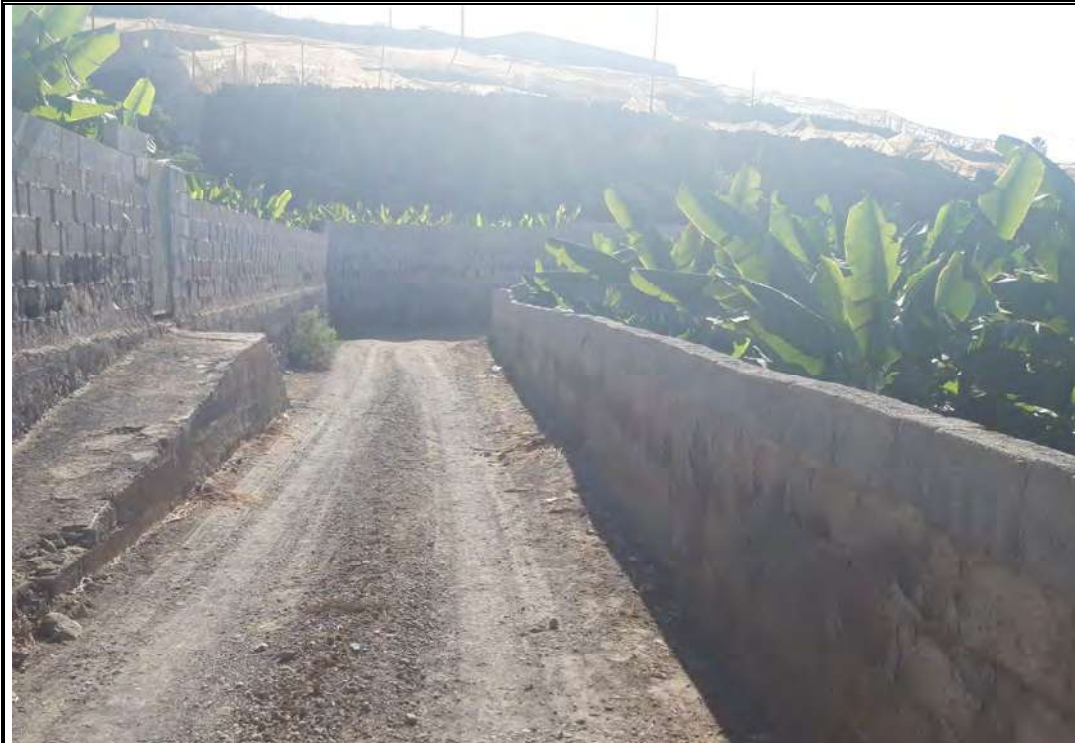
Imagen 19: PK 1.380. Protección de borde al ancho disponible en ambos márgenes.
