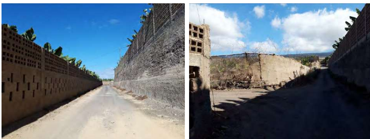
Tramos que no se asfaltarán.
