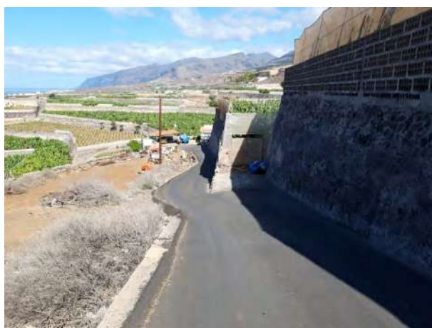
PK 1+080 con estrechamiento.
