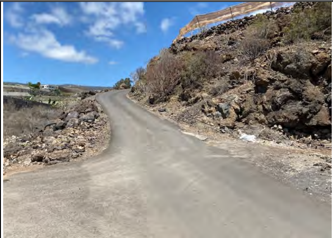
Imagen 16: PK 1.290. Ejecución de muros de contención en ambas márgenes de camino.
