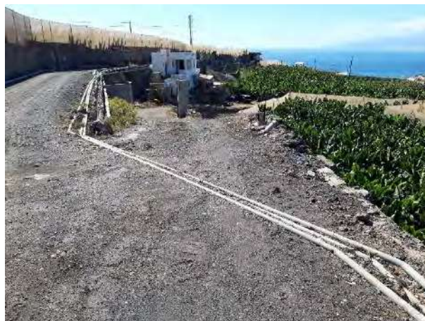
Tuberías que se deberán soterrar para la ejecución de la entrada a parcela.
