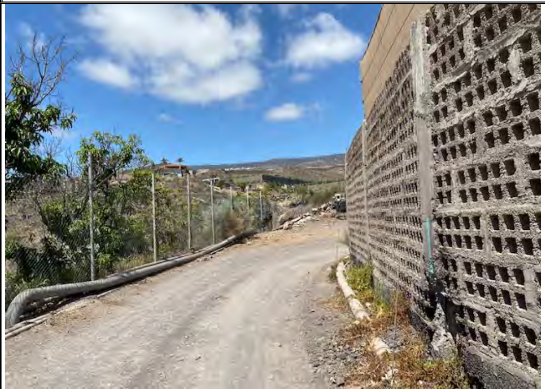
Imagen 9: PK 650. Zona a ejecutar apartadero en exterior de la curva.
