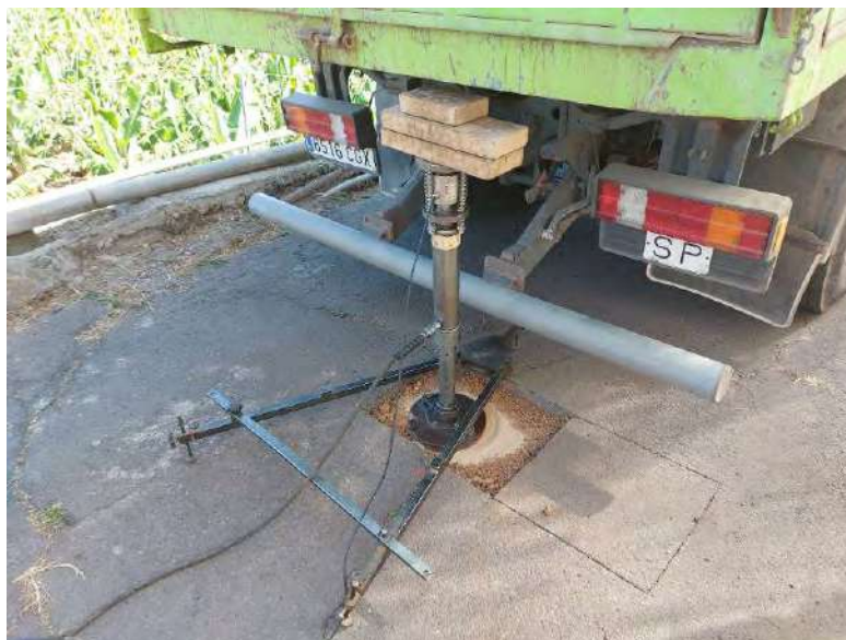
Ilustración 9: Prueba de carga Pk 1+010
