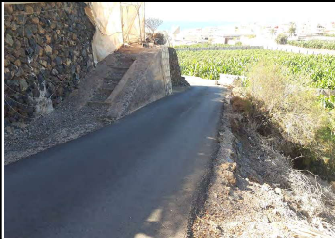
Imagen 20: PK 1.260. Entrada a finca por escalera existente.
