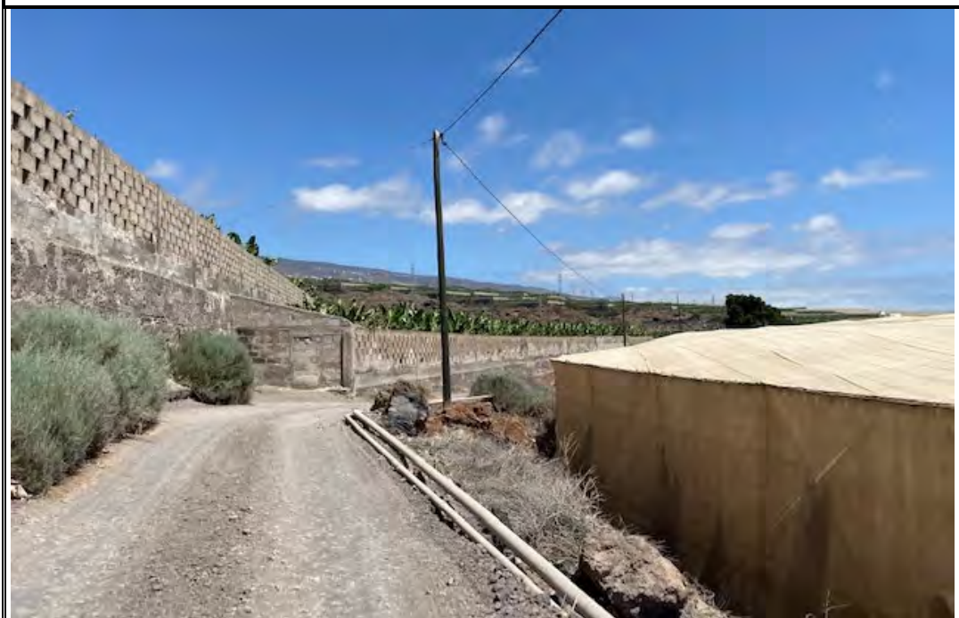
Imagen 3: PK 120, vista del sobrecancho existente, a desbrozar, limpiar y desplazar conducción y poste d madera existente.
