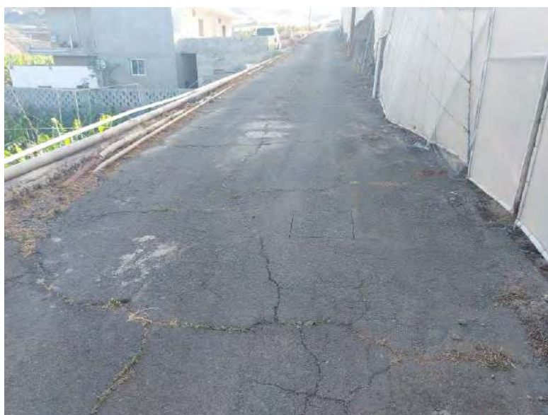
Ilustración 10: Vista general de prueba en PK 1+010.
