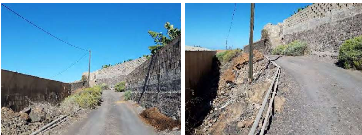
Vista del lugar de donde se encuentra el poste de madera.
