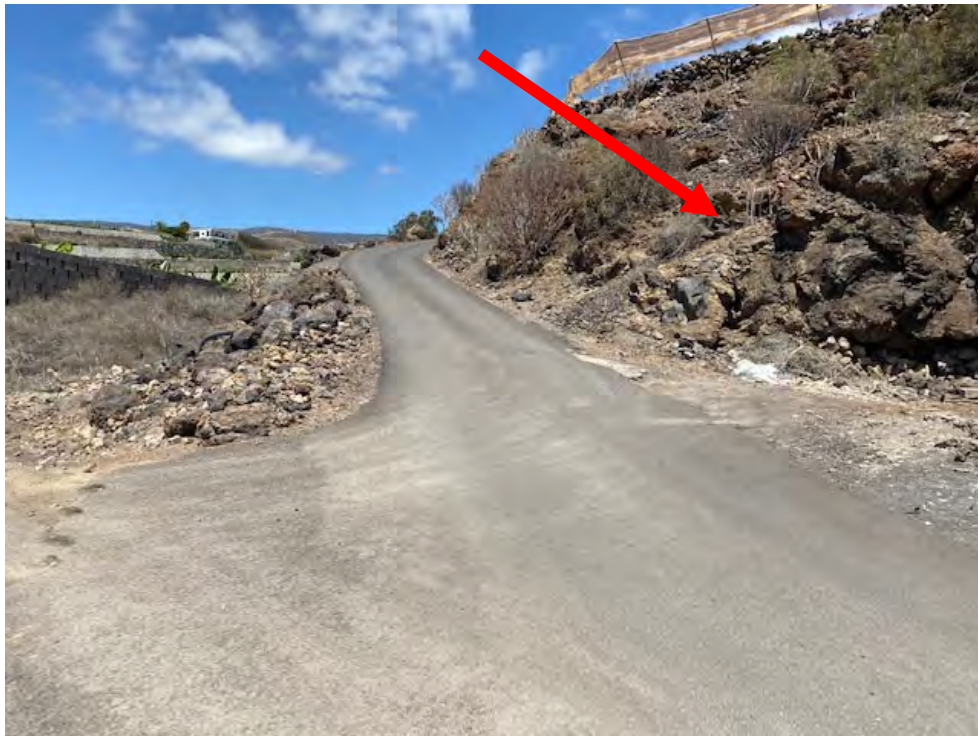
Muro de contención
