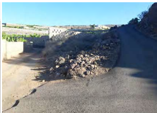
Entronque de la calle Finca Lomos Los Cerrillos con el Camino La Cumbrita.
