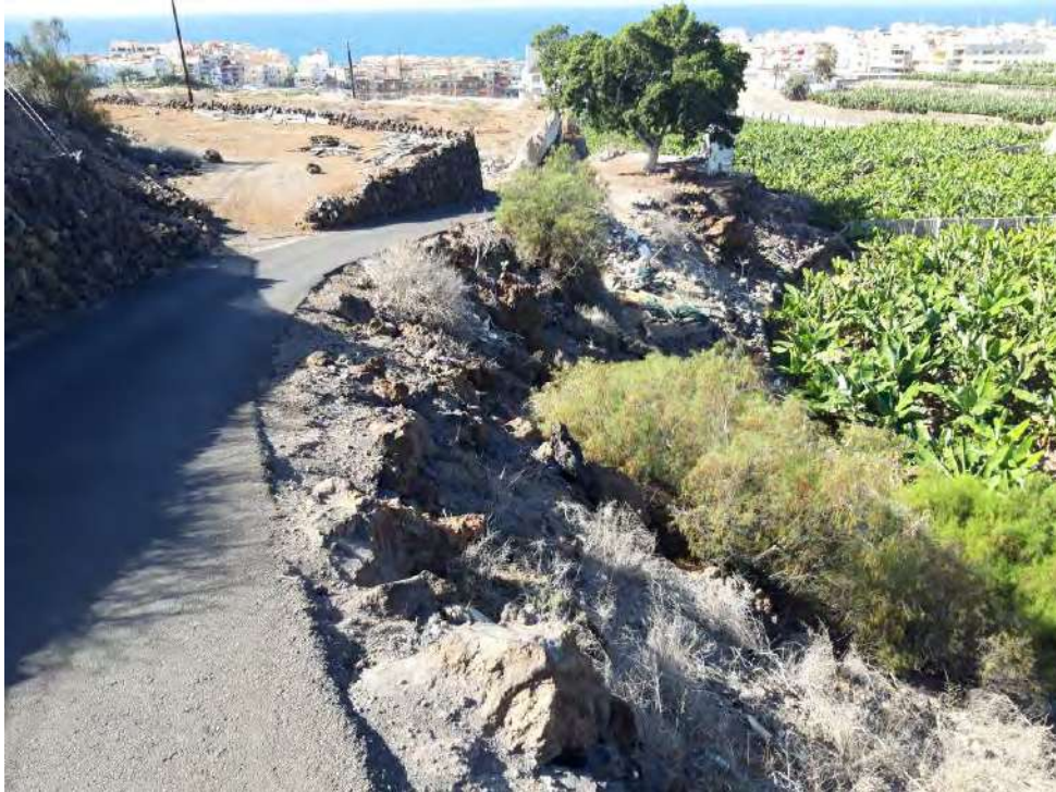
Ejecución de muro de contención en la margen derecha del camino
