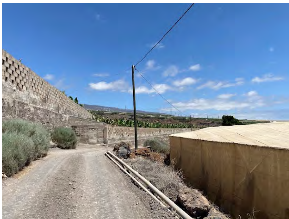
Apartadero a asfaltar. Parcela 320, a la izquierda de la imagen
