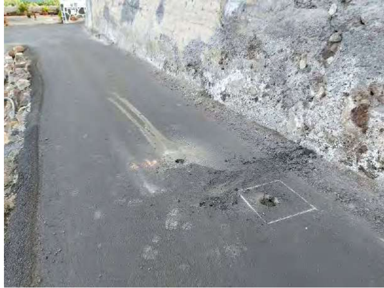
Ilustración 12: Vista general de prueba en PK 1+125.
