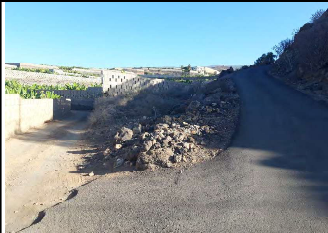
Imagen 18: PK 1.330. A partir de este punto, el muro de contención sobre rasante 50cm a modo de murete 3 caras vistas.
