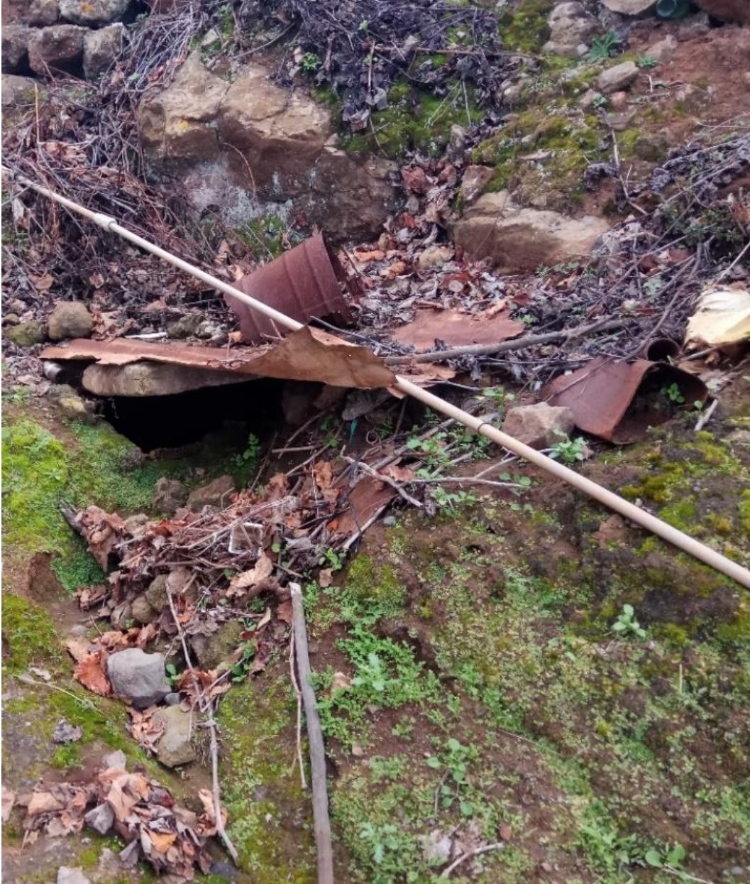
Imagen 6. Tanquilla de acumulación de agua de escorrentía
