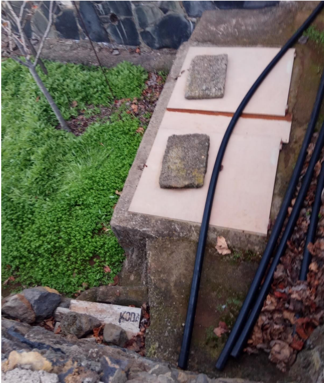
Imagen 11. Tanquilla de acumulación de agua de escorrentía dentro de la finca
