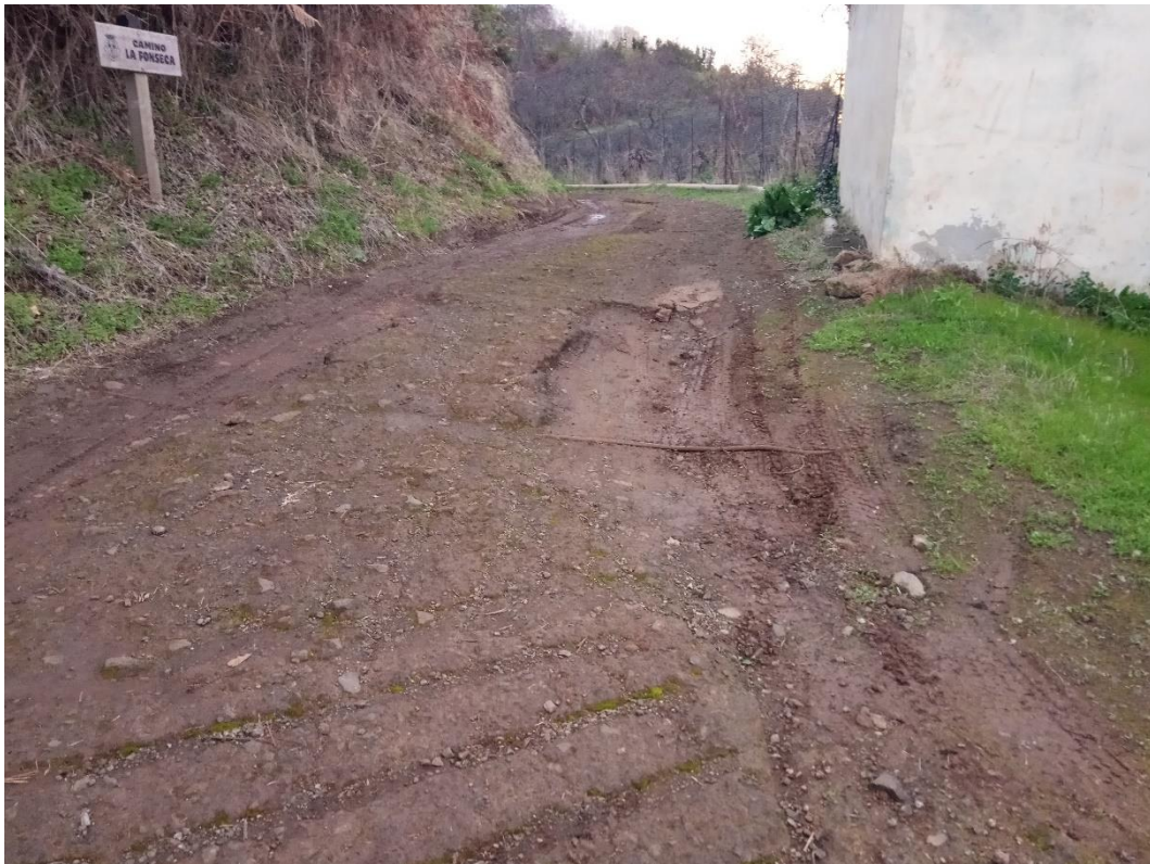
Imagen 59. Cruce de tubería de abastecimiento y tubería de BALTEN de 6" Acero galvanizado.
