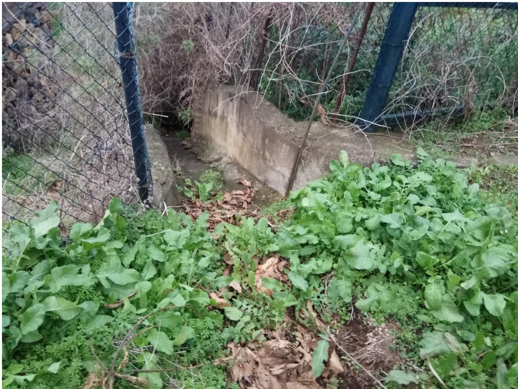
Imagen 65. Bco. La Mina aguas abajo.
