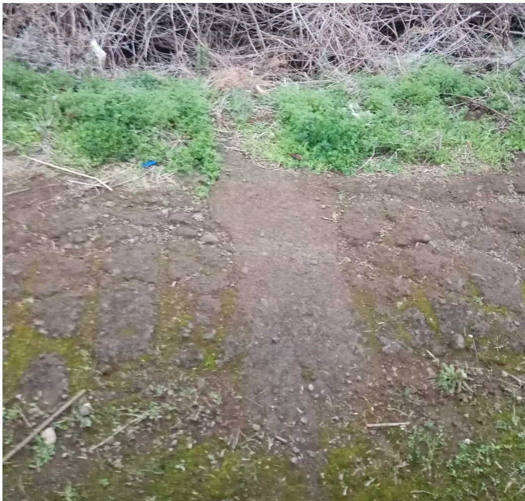
Imagen 52. Paso transversal tubería BALTEN de 6" en acero galvanizado.
