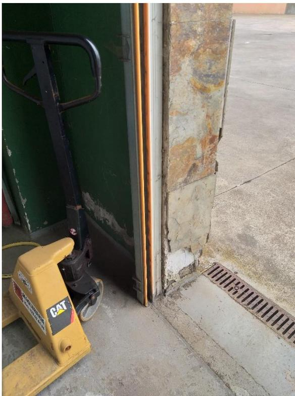
Fotografía 12. Desprendimiento de aplacado en fachada y pérdida de la capa de pintura por capilaridad.
