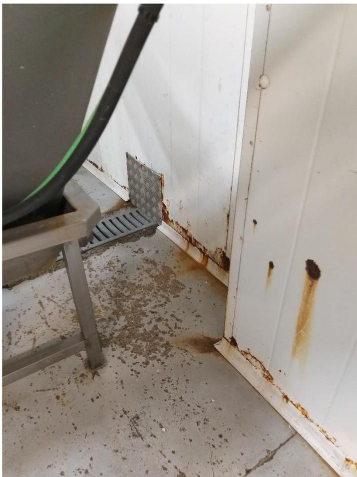
Fotografía 18. Oxidaciones en los cerramientos metálicos y sanitarios de la nave principal.
