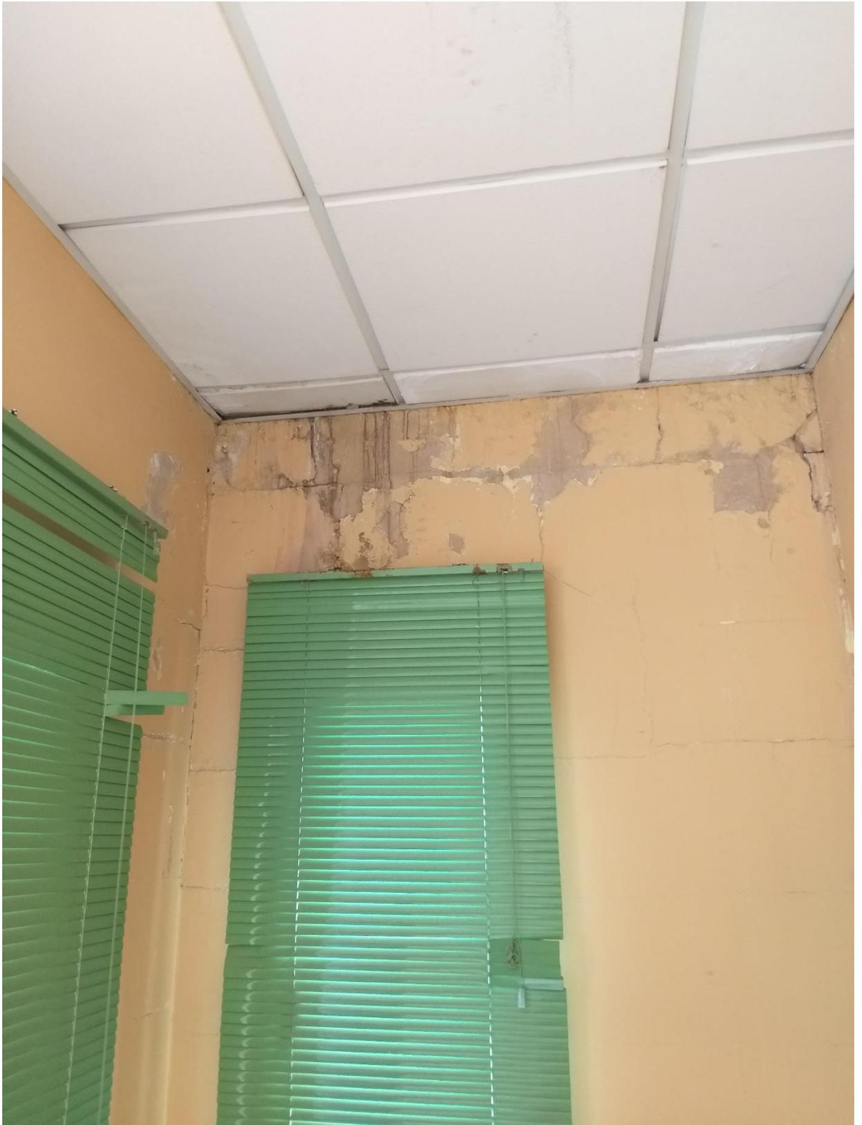
Fotografía 8. Efecto de rotación en la fachada en el pasillo II de la planta alta . Aparición de grieta horizontal en la parte alta. Filtraciones de agua.
