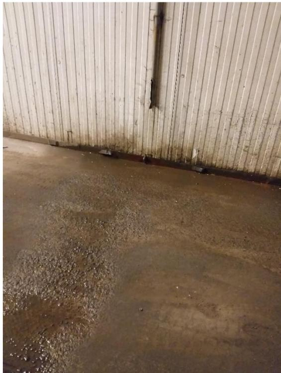
Fotografía 17. Acumulación de agua procedente de los condensados de los equipos de frío industrial
