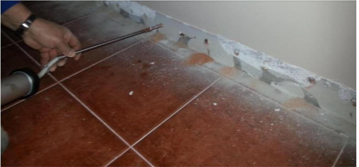
Fotografía 20. Proceso de inyectado de resina contra el fenómeno de capilaridad.
