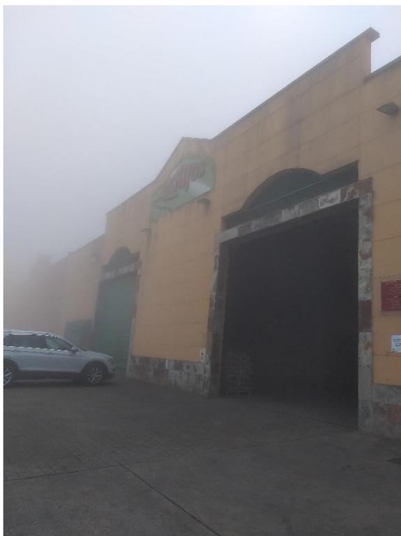
Fotografía 13. Suciedad en la fachada debido al agua de lluvia.
