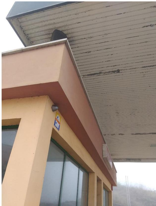
Fotografía 15. Acabado deteriorado del cerramiento metálico de la marquesina de la gasolinera.
