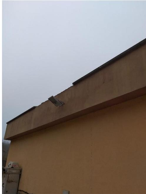
Fotografía 14. Suciedad en la fachada (edificación de la gasolinera) y rotura del existente.
