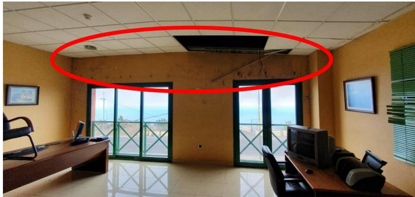
Fotografía 1. Rotura de falso techo por humedad por filtración o accidente. Fisuras horizontales, verticales y diagonales. Abombamiento de muro.
