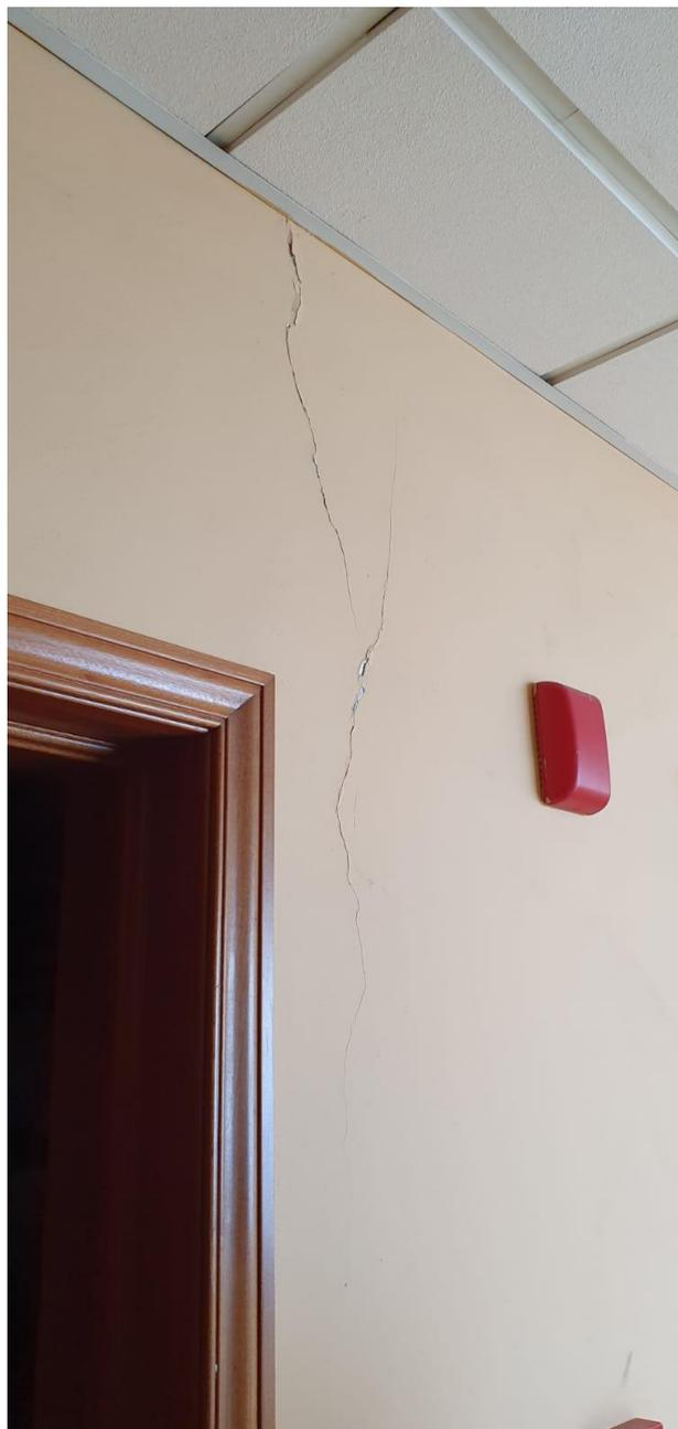
Fotografía 9. Fisura en paramento vertical interior, por grietas de dilatación.
