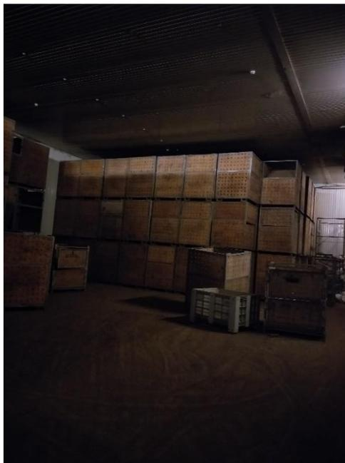
Fotografía 19. Deficiencia en la iluminación de las cámaras frigoríficas.
