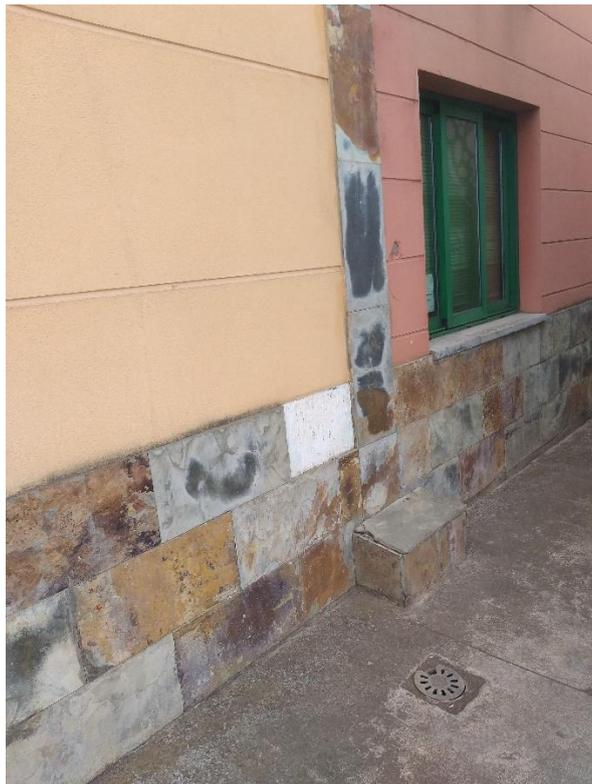
Fotografía 11. Desprendimiento del aplacado de la fachada.
