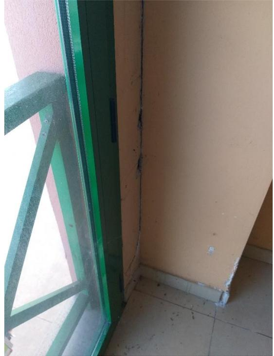
Fotografías 2 y 3. Fisuras verticales en la esquina derecha de la fotografía 1
