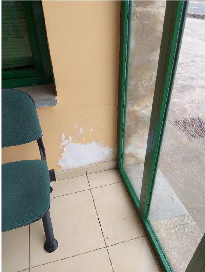
Fotografía 10. Efecto de la humedad por capilaridad sobre la capa de pintura.
