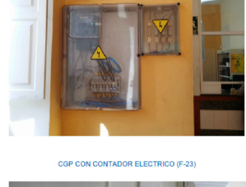
CGP CON CONTADOR ELECTRIC (F-23)
