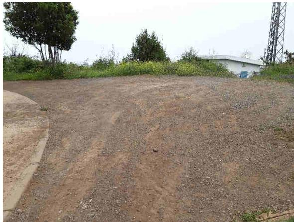
Las actuaciones a realizar son básicamente la demolición de los badenes de hormigón para su posterior ejecución con mejora de la pendiente transversal para evitar la salida de las aguas de escorrentías.
