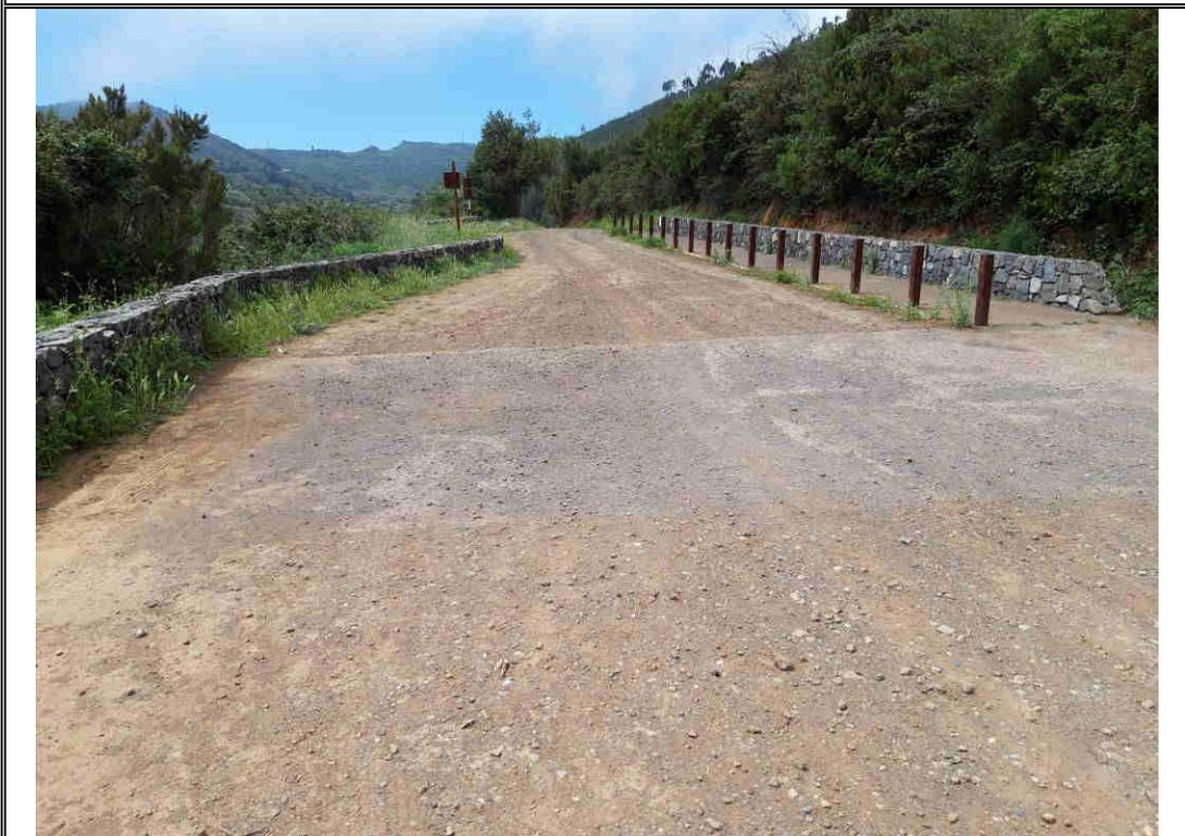
Imagen 3: Badén en la zona de estacionamientos a demoler
