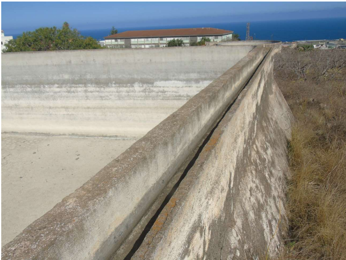
Detalle de las distintas infraestructuras hidráulicas de conducción y de almacenaje presentes en el interior de este espacio agrícola
