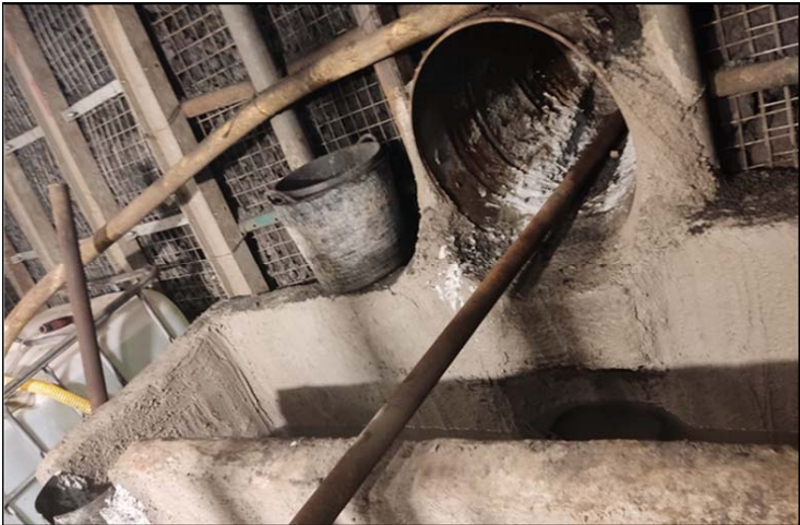
Vista emboquille del sondeo.
