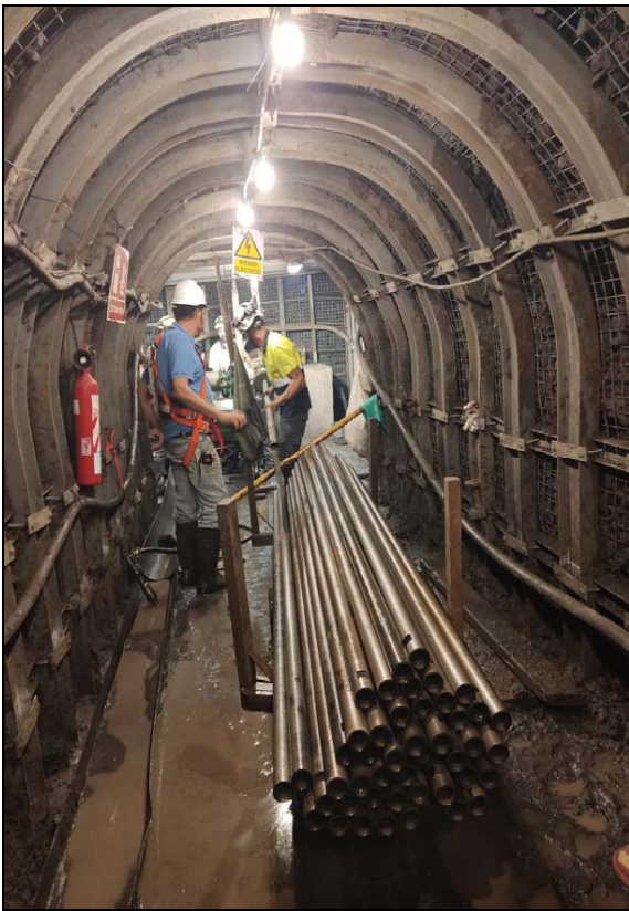
Vista extracción varillaje.
