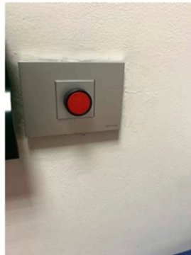
Pulsador de corte de la señal situado en el exterior de la cabina.
