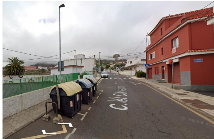
Vista de tramo de Calle El Calvario
