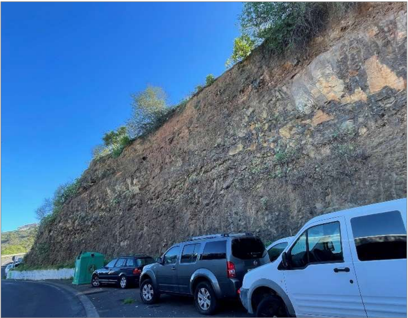
Figura 25 Detalle de un talud externo representativo conformado por coladas basálticas
