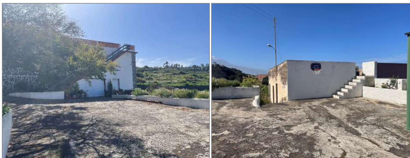
Figura 59 Detalles fotográficos de edificaciones presentes en el interior del Sector 8-Las Breñas
