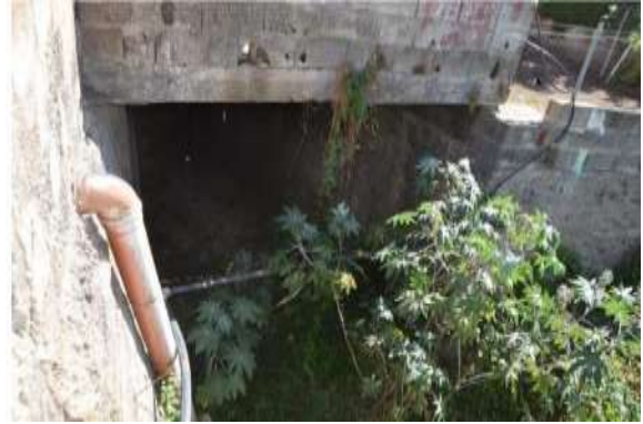
Foto 10. Obra de Drenaje Transversal (canalización) del Bco. Seco que atraviesa la TF-13
