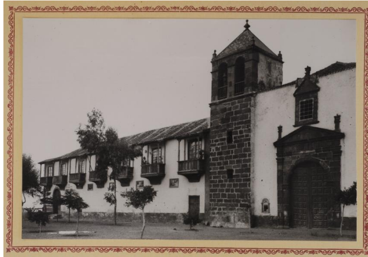
Ilustración 13. Obras de mejora en el Hospital de la Concepción. Foto Zenón (1945) 8
