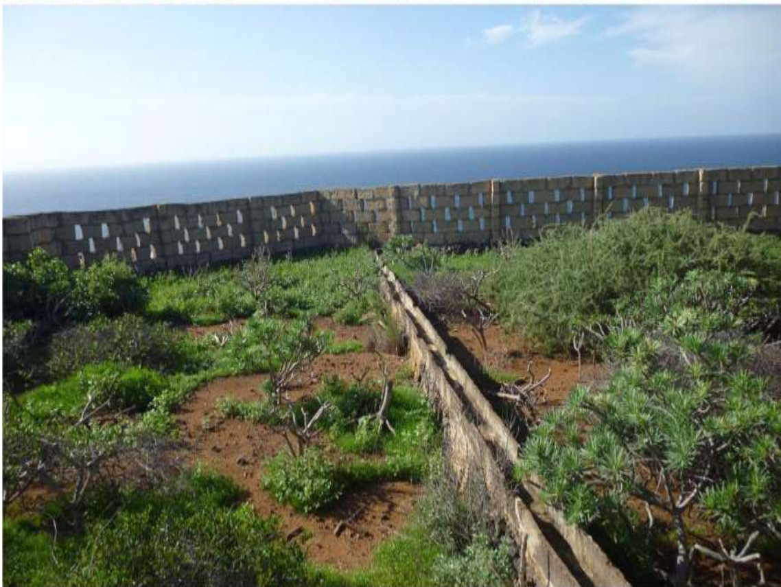
Vista de una de las tanquillas y detalle de un bancal con muro cortaviento y atarjeas.
