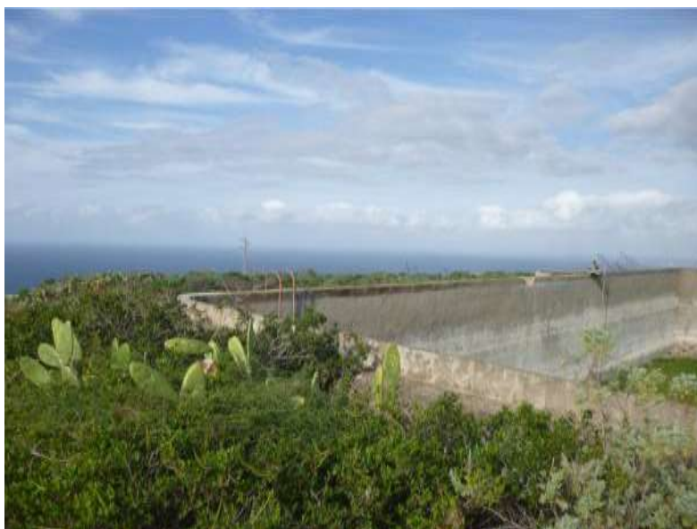
Estanque ubicado en la parcela situada por encima de la carretera TF-163.
