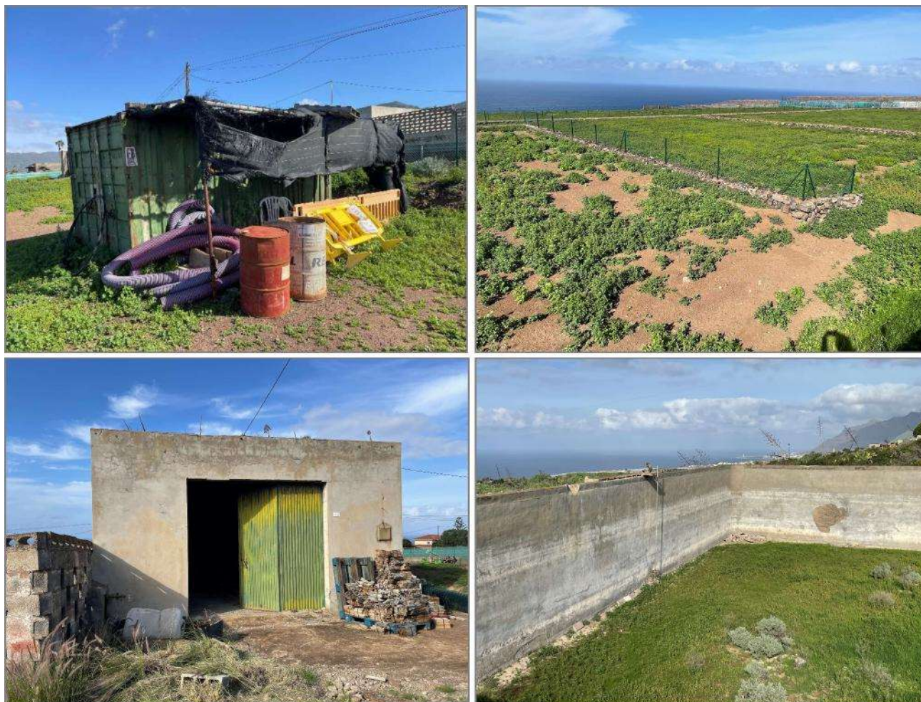
Figura 82. Detalles de instalaciones presentes en el interior del ámbito objeto del PII-PCA. Fuente: elaboración propia
