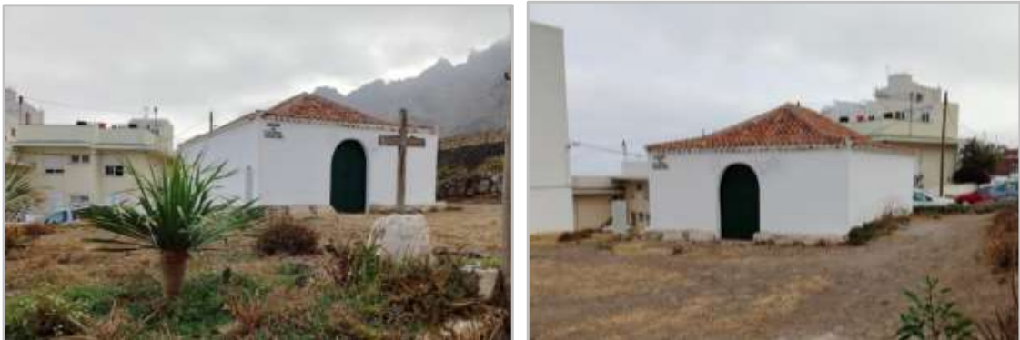
Figura 2. Estado actual (10/08/2025) del ámbito territorial de la Modificación Menor del PGO. Fuente: Elaboración propia.
