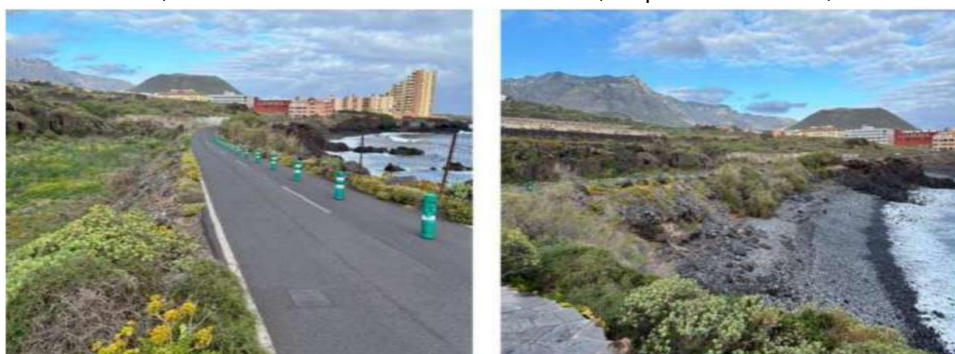
Figura 3. Fotografías del "camino de la costa" que discurre dentro del ámbito territorial de la presente Modificación Menor. Fuente: Borrador del Documento de Ordenación.
