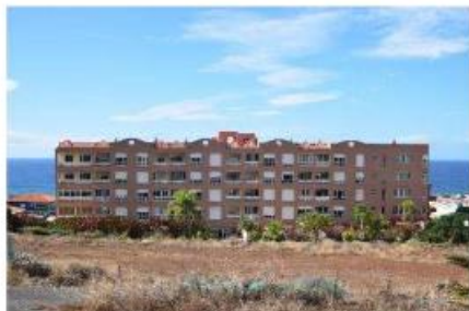
Foto 5. Edificaciones. Límite Oeste
