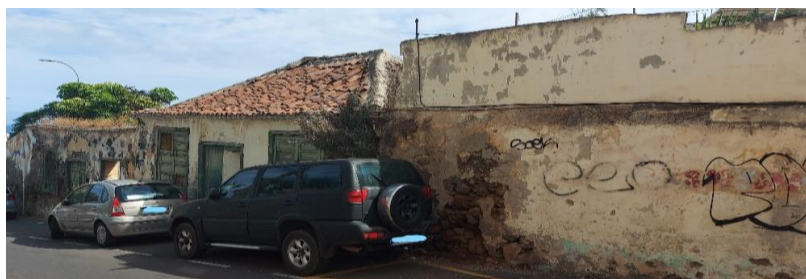
Estado actual de las edificaciones a proteger por el proyecto de urbanización en la C/ Esquilón bajo (nº 5 y 7). Fuente visita de campo personal de la oficina.
