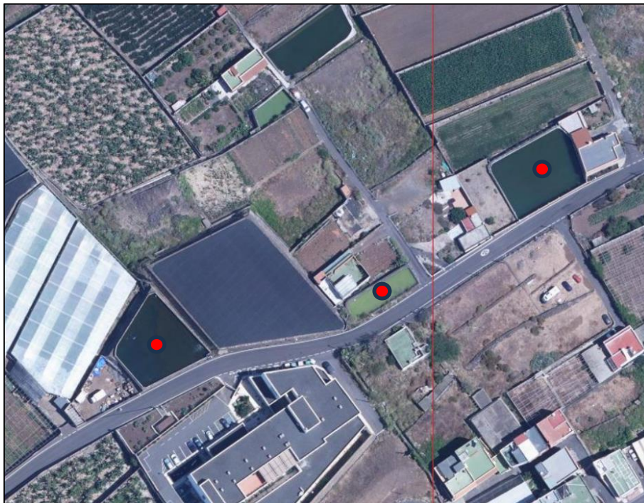
Conjunto de tres depósitos existentes al norte del Camino de Palenzuela.
