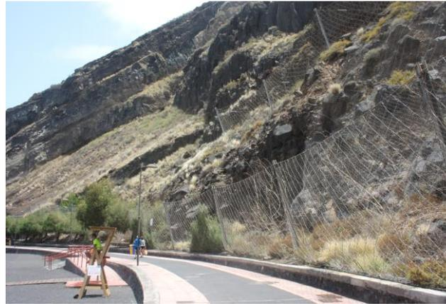
Detalle de pantallas dinámicas instaladas junto a paseo litoral.
