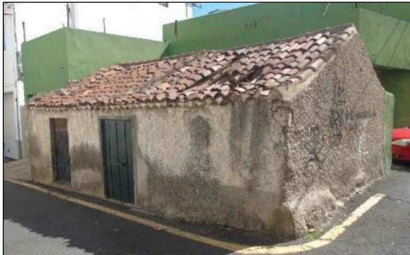
*Imagen 27. La ausencia de mantenimiento de la cubierta (reposición de tejas y tratamiento del armazón) puede suponer la desaparición del inmueble. En ese caso, además se ha sustituido la carpintería original de los vanos por materiales más modernos.*
