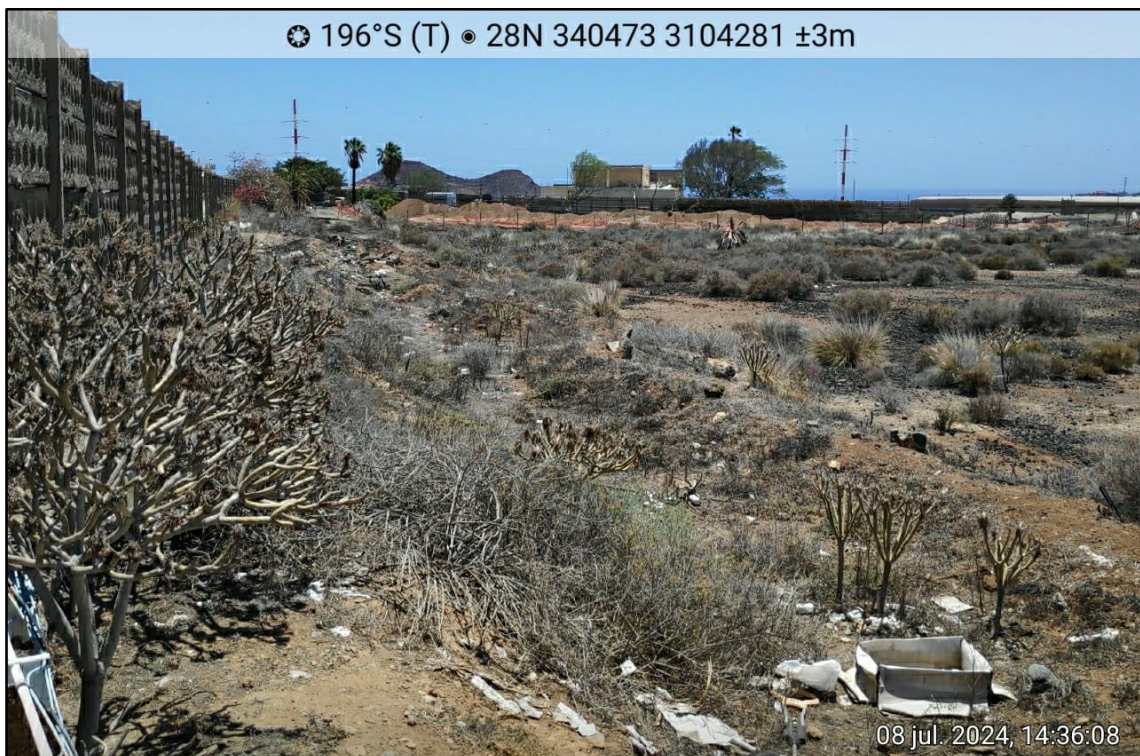
Fotos 1-2 Estado actual de la parcela en estudio Oroteanda Alta
