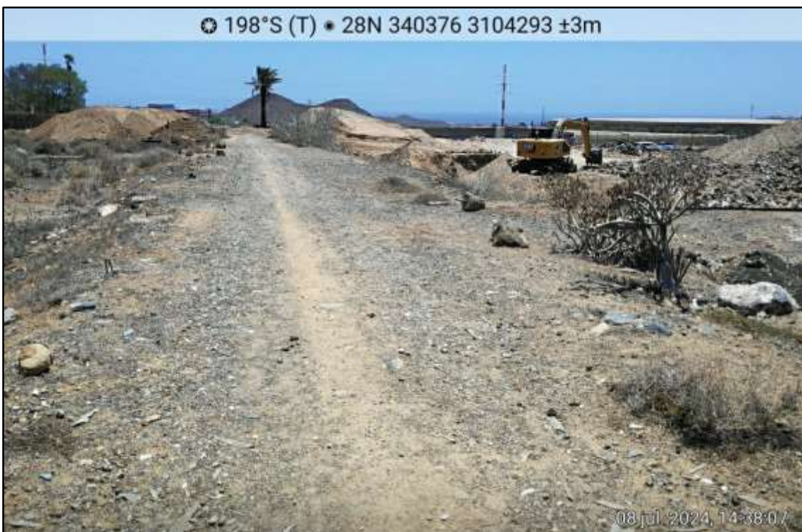
Fotos 7-8 Estado actual de la parcela en estudio Oroteanda Alta
