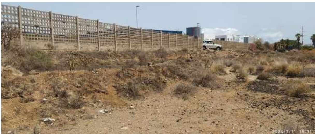
Muros parcelarios. Fuente: Elaboración propia
