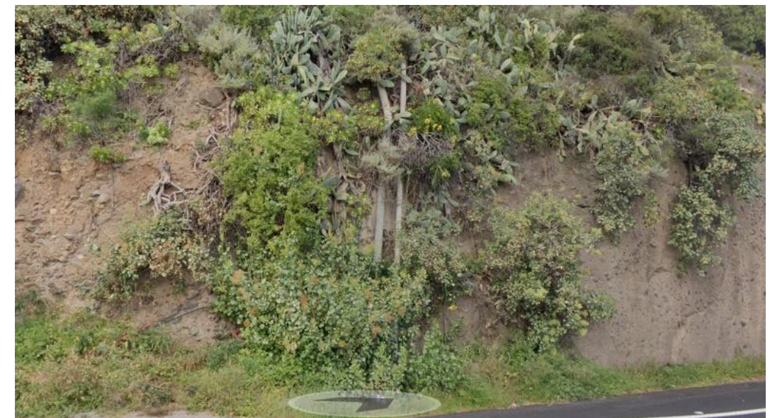
Imagen 107. Tuberías de abastecimiento existentes en la zona de actuación
