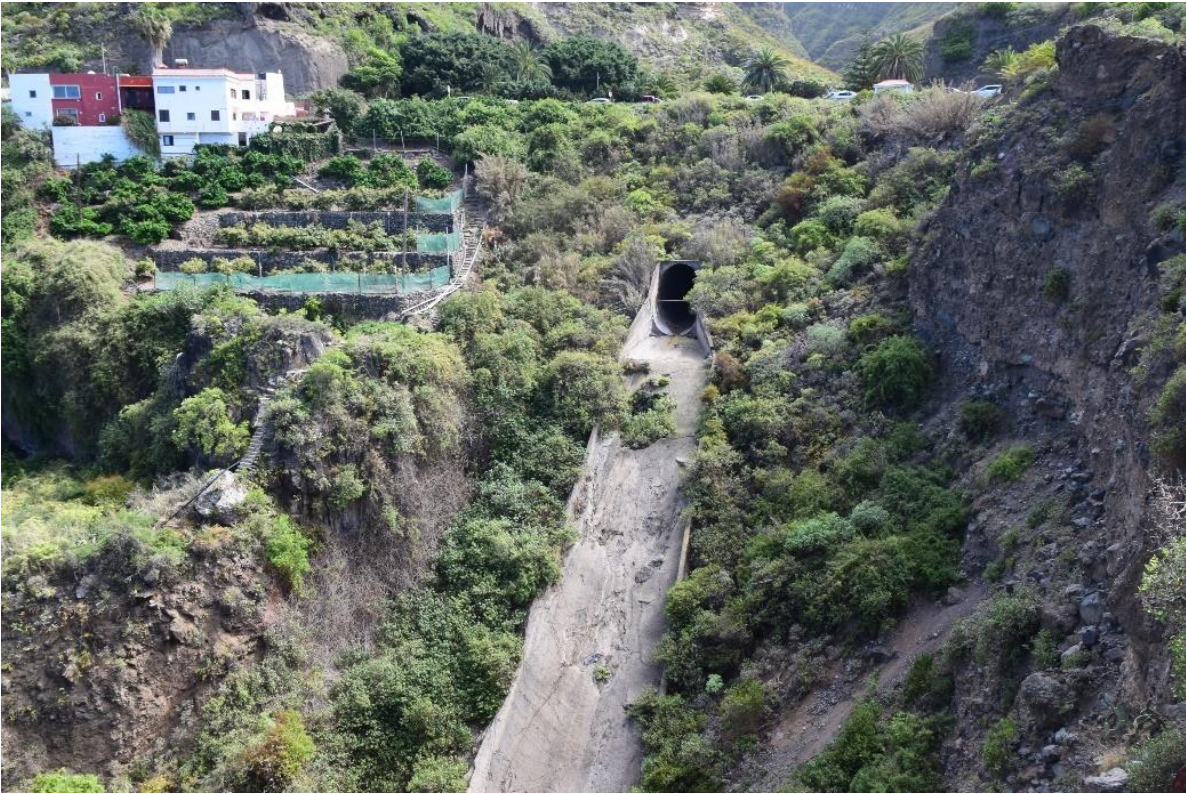
Foto 59. Zona prevista, entre la ODT y TF-5, para la ejecución de muros de tierra armada
