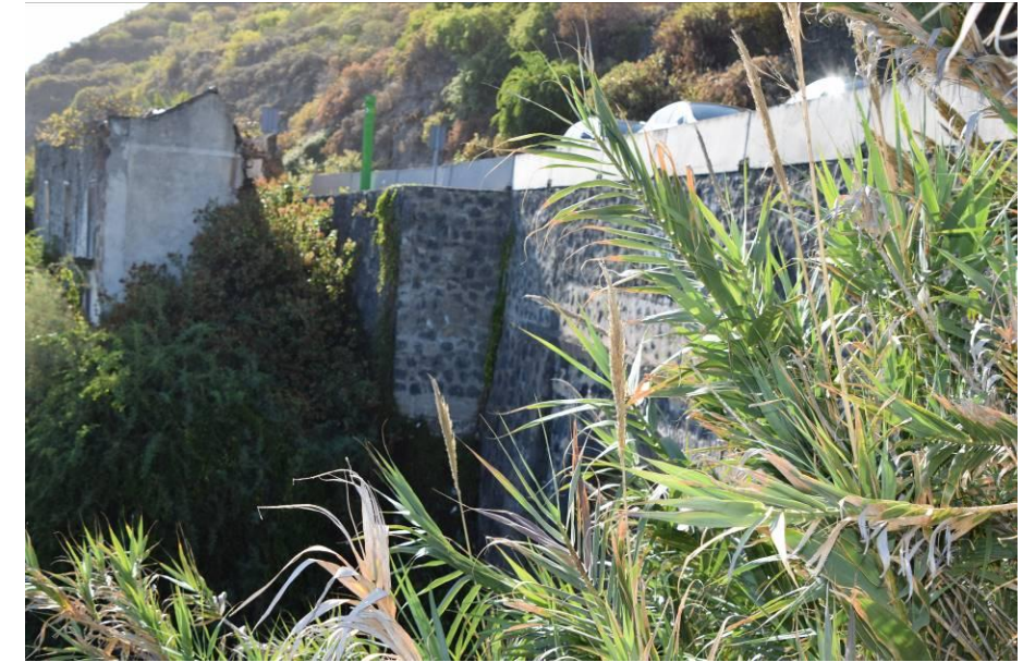
Foto 64. Revestimiento con piedra natural basáltica en la obra de fábrica del barranco de San Antonio
