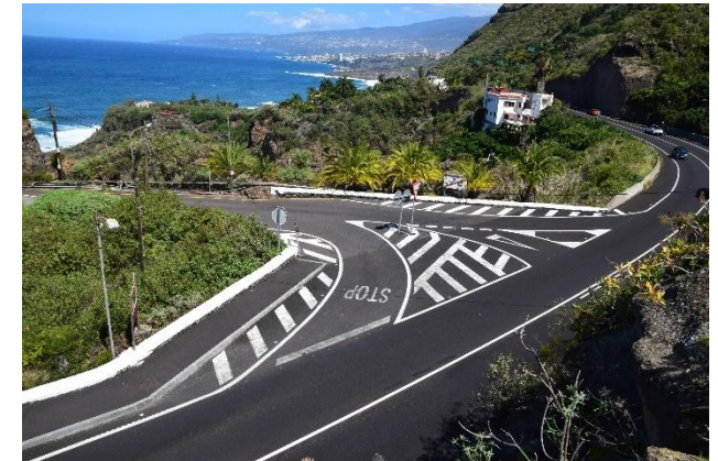
Foto 38. Acceso/Salida desde/hacia la TF-5 al núcleo de El Rosario
