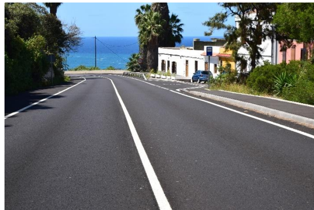
Foto 36. TF-5 sentido Icod tras el acceso al núcleo de El Rosario
