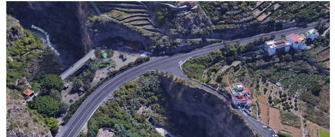
Imagen 84. Intersección P.K. 44+600 de la TF-5 (Acceso a El Rosario)
