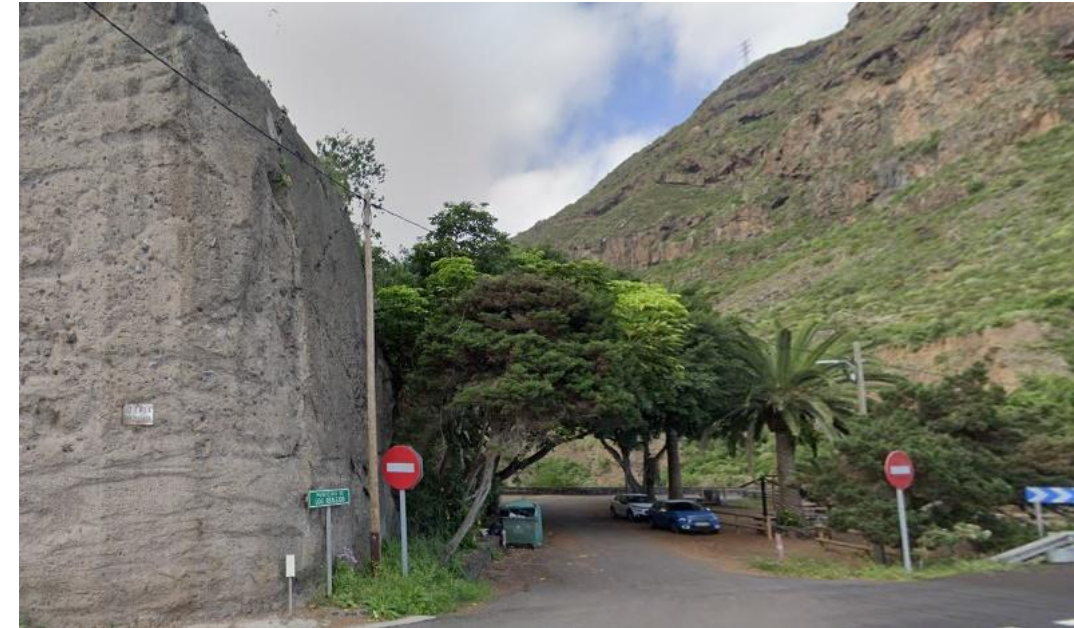
Imagen 109. Línea aérea de telecomunicaciones afectada por las obras
