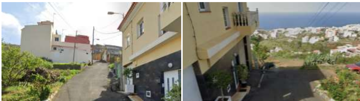
Imagen 139. Estado actual Calle Lomo La Mina. Fuente: Servicio de Google Street View 2024.
