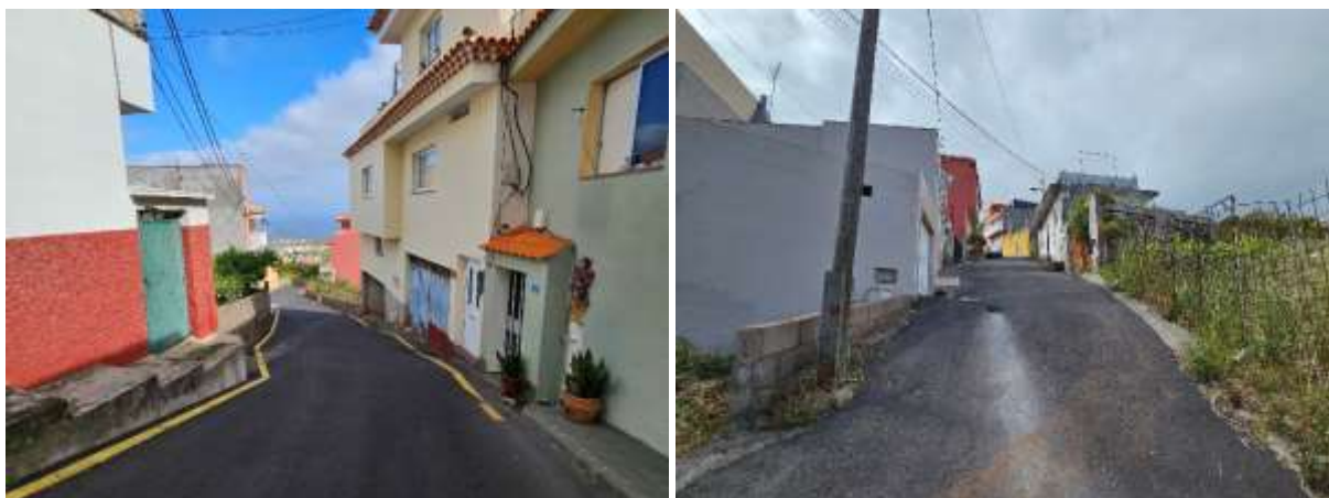
Imagen 135. Detalle de las edificaciones en la Calle Lomo La Mina. Fuente: Propia.
