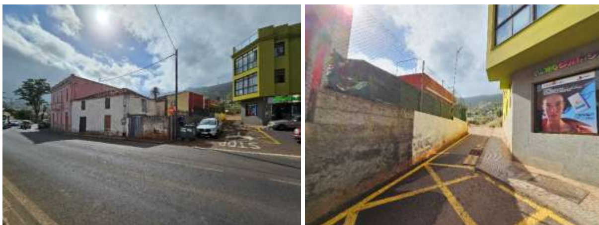
Imagen 117. Izquierda: Conexión del sendero agrícola con la carretera TF217. Derecha: Detalle del paso existente. Fuente: Propia.
