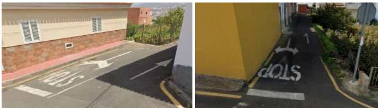
Imagen 176. Izquierda: Conexión de la calle Granadillo con Zumacal. Derecha: Conexión de la calle Granadillo con Los Zarzales Fuente: Servicio de Google Street View 2024.
