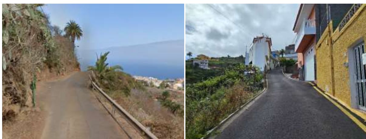
Imagen 129. Derecha. Calle Fuente Gonzalo. Izquierda. Calle Lomo La Mina. Fuente: Propia.
