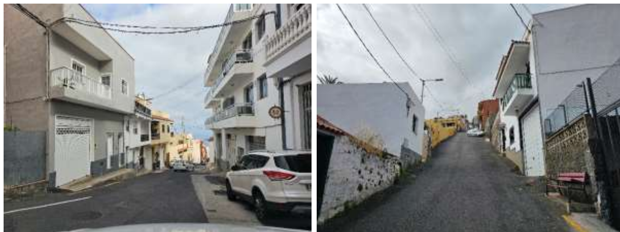
Imagen 95. Izquierda. Edificaciones de la calle El Farrobillo. Derecha. Edificaciones de la calle Barranquillo Fuente: Propia.
