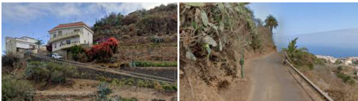
Imagen 140. Viario de acceso por la calle Fuente Gonzalo. Fuente: Propia.
