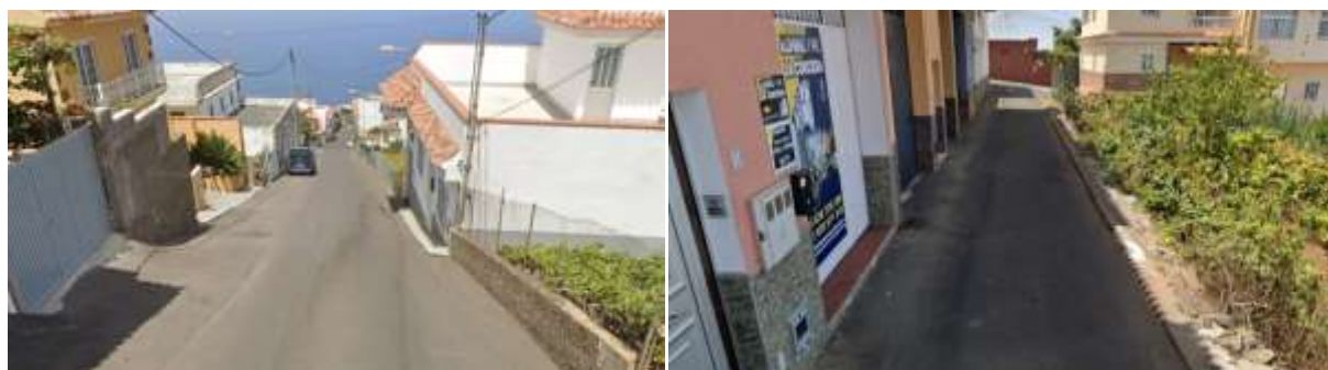
Imagen 184. Izquierda: Discontinuidad de aceras en la calle Zumacal. Derecha: Falta de infraestructura peatonal en la calle Granadillo. Fuente: Servicio de Google Street View 2024.
