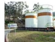
El aceite desclasificado, con un contenido en humedad inferior al 10%, se almacena en unos tanques hasta su **aprovechamiento final** como sustitutivo de otros combustibles fósiles (fuel, carbón, etc.) en instalaciones de producción de energía eléctrica, o bien como **lubricante** en determinados procesos industriales.
