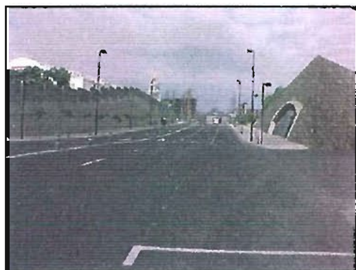
AVENIDA LA SALLE
