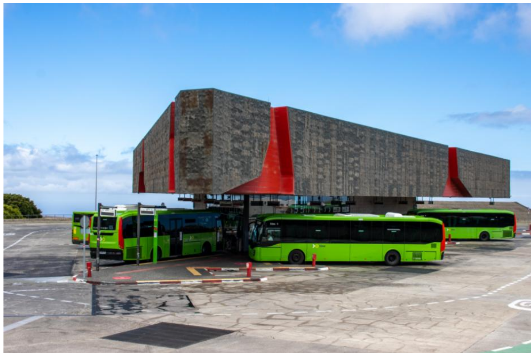
Figura 25. Intercambiador de Transporte en San Cristóbal de La Laguna (Padre Anchieta)
