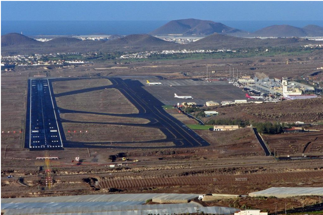
Figura 42. Aeropuerto Tenerife Sur
