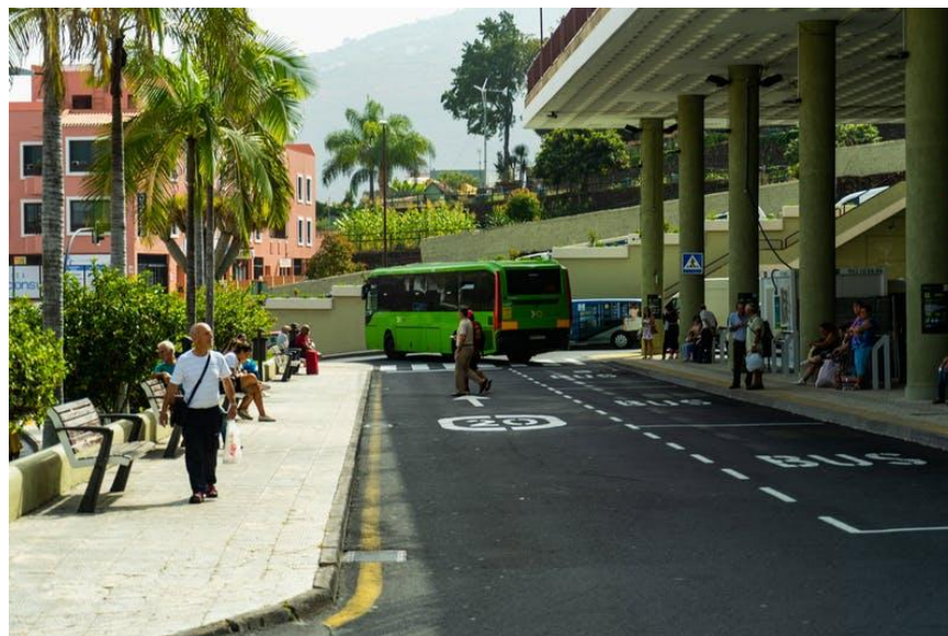
Figura 14. Estación de guaguas de La Orotava
