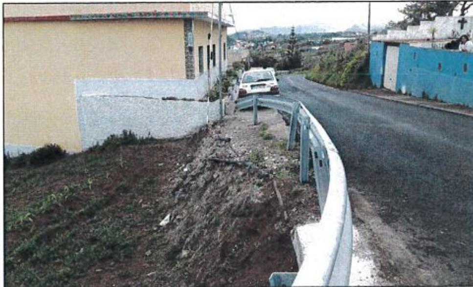
Imagen estado final del tramo instalado del SCV tipo bionda metálica
