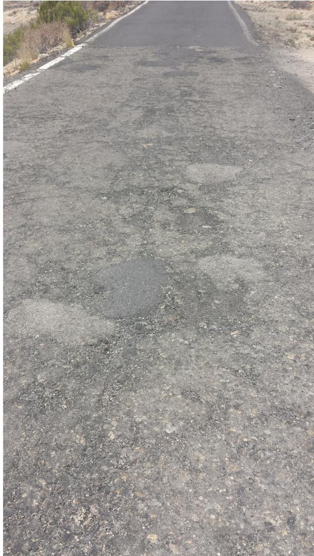
*PK 0+350 Fisuraciones generalizadas, baches y descarnados con pérdida de capa de rodadura*
