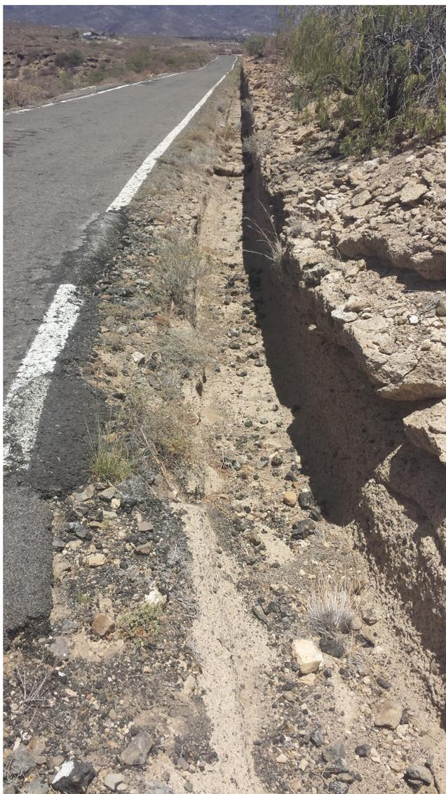
*PK-2+000. Cuneta de tierra muy profunda. Se requiere revestir con hormigón la cuneta de tierra, conformando una cuneta asimétrica con pendientes suaves, eliminando de ésta manera el riesgo para los conductores si llegara a caer una rueda en la cuneta.*
