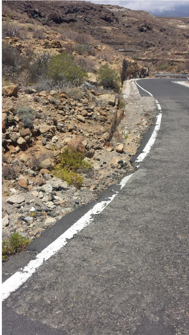
*PK-1+050. Cuneta de tierra con depósitos de acarreo. Se requiere revestir con hormigón la cuneta de tierra, dándole continuidad a la cuneta de hormigón que se muestra en la imagen.*
