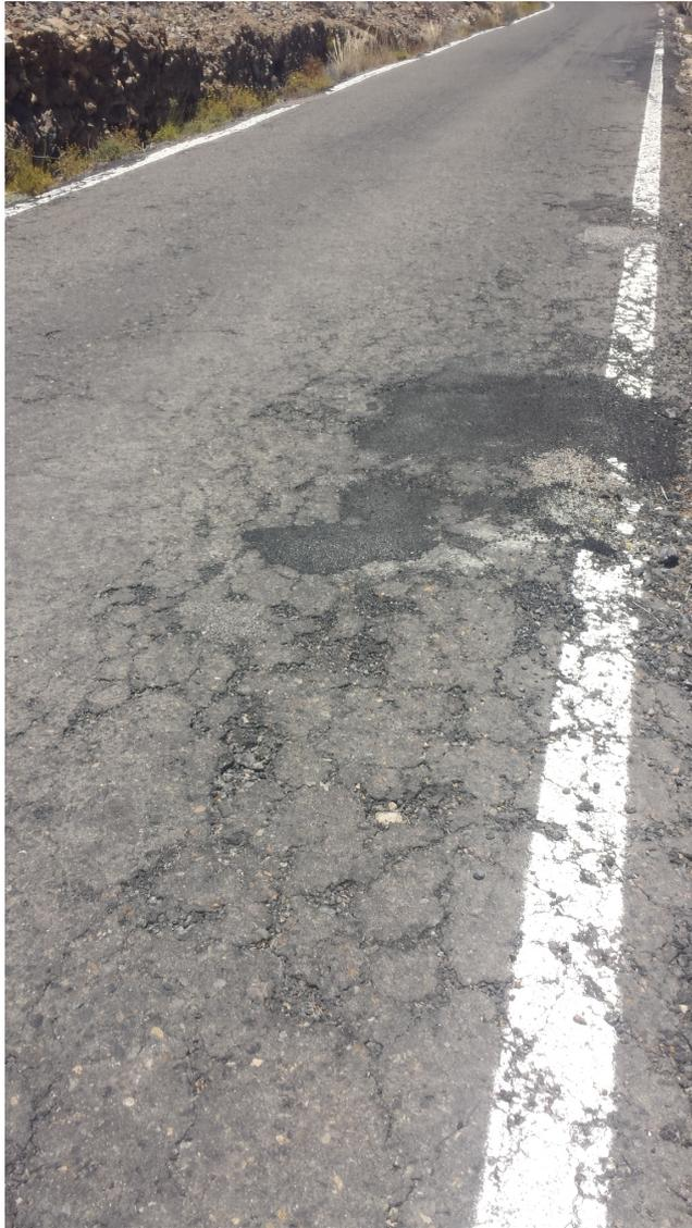
*PK 2+400 Fisuraciones en doble malla fina y descarnados con pérdidas de capa de rodadura que han sido reparadas.*
