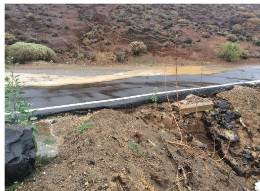
*Erosión sobre el margen izquierdo de la calzada*
