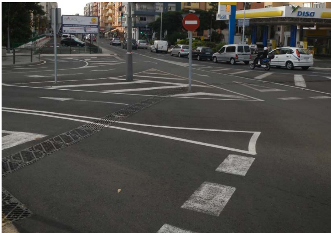
Foto 18.- Imbornales existentes en rotonda de la Avda. Venezuela
