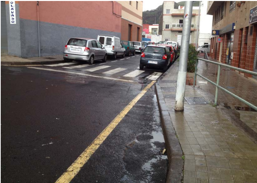
Foto 29.- Rejilla existente en C/Antequera y Bobadilla
