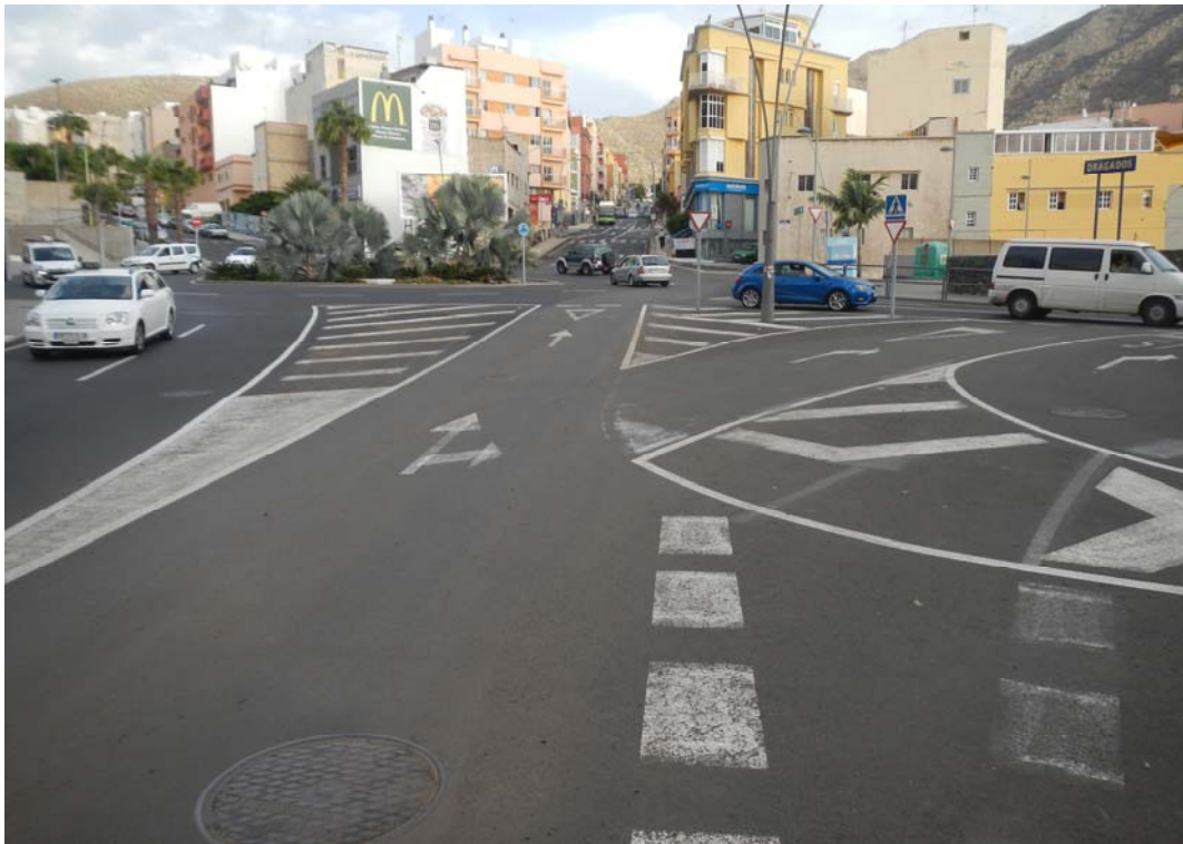
Foto 17.- Vista rotonda desde la zona baja de la Avda. Venezuela
