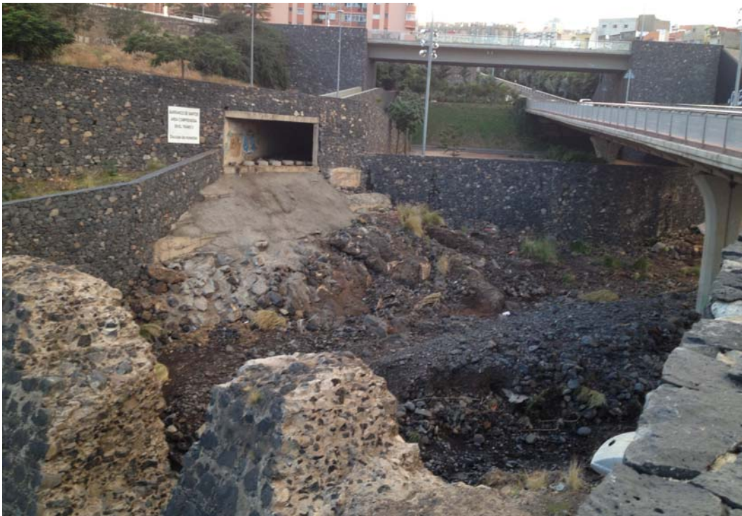
Foto 23.- Desembocadura del encauzamiento del bco. de Macario en el bco. de Santos
