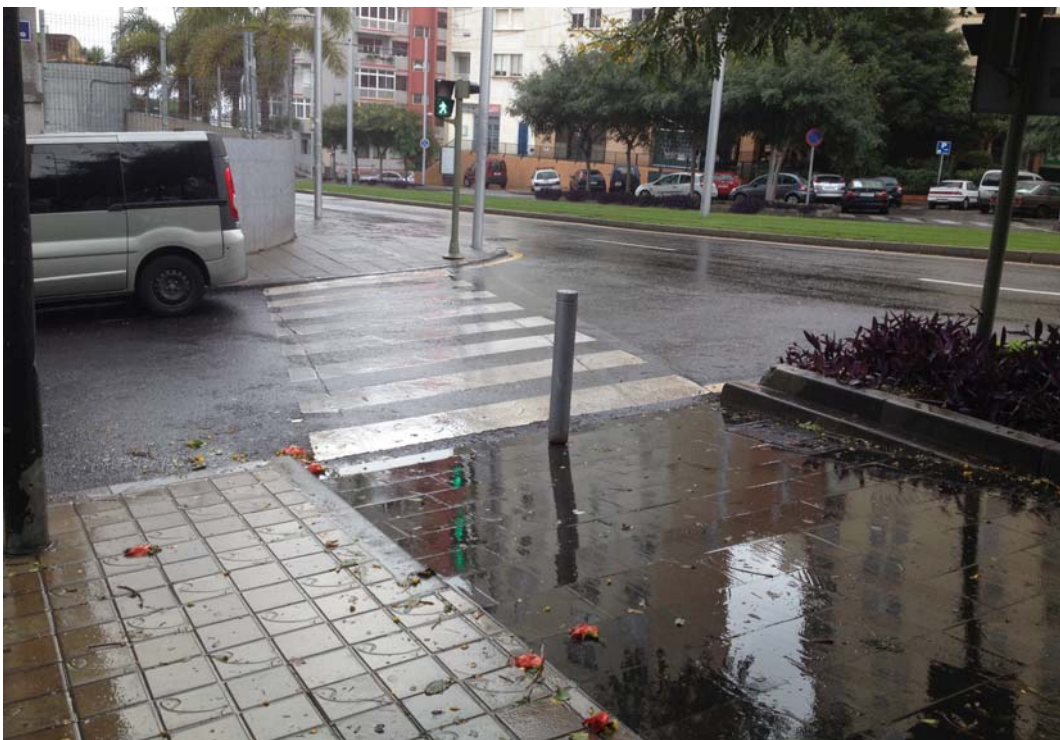
Foto 28.- Paso de peatones en C/Santiago Beyró
